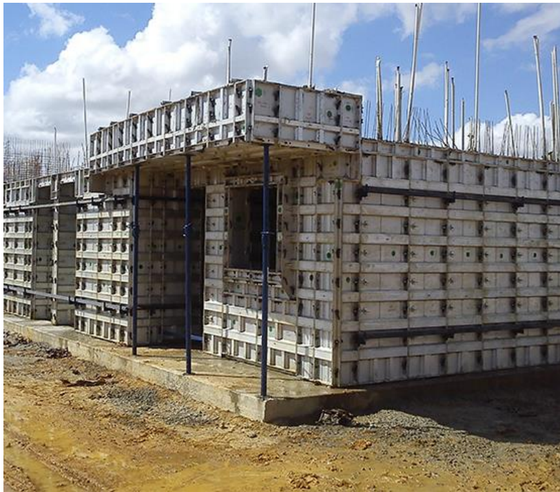
Figura 2. Montaje de placa metálica
