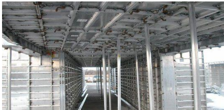
Figura 1. Sistema de placa metálica
