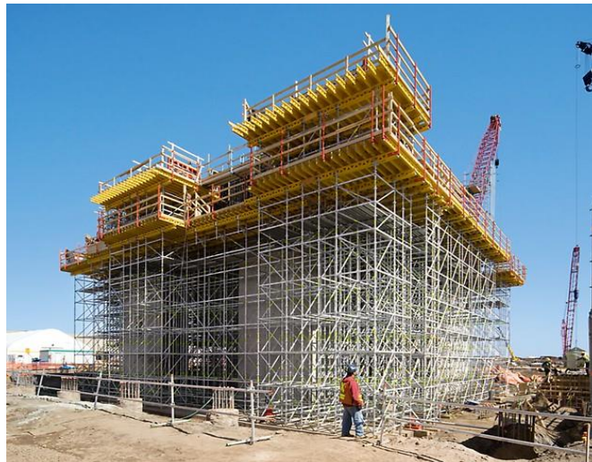
Figura 5. Sistema combinado para losas de gran altura
