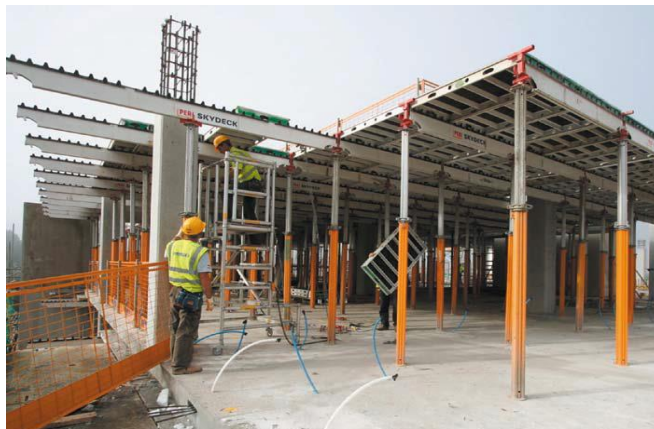
Figura 3. Montaje de panel horizontal
