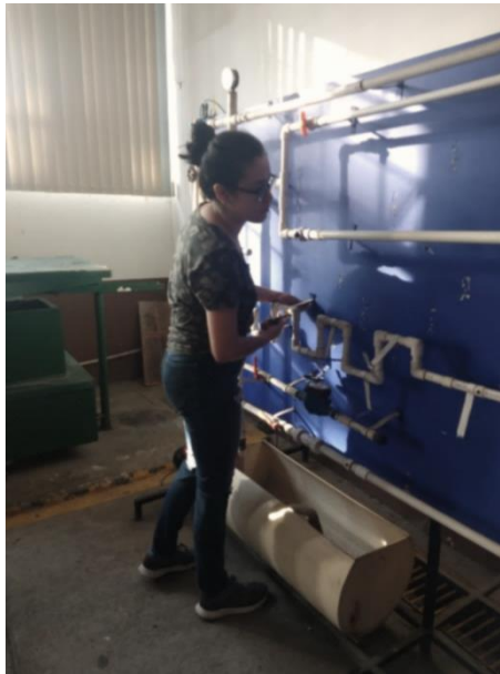
Figura 36. Desmantelado del sistema obsoleto
