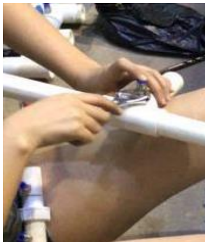
Figura 39. Instalación de racores
