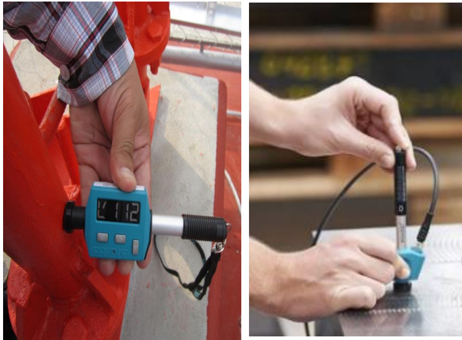
Figura 19. Medición de dureza en montante de torre
