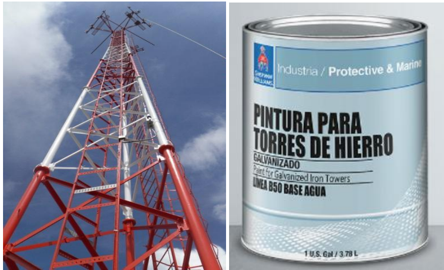
Figura 28. Pintura en torre autoportada
