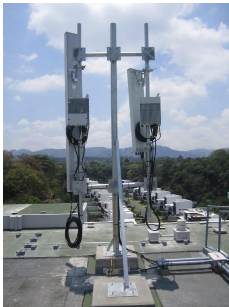
Figura 6. Acero utilizado en soportes de antenas
