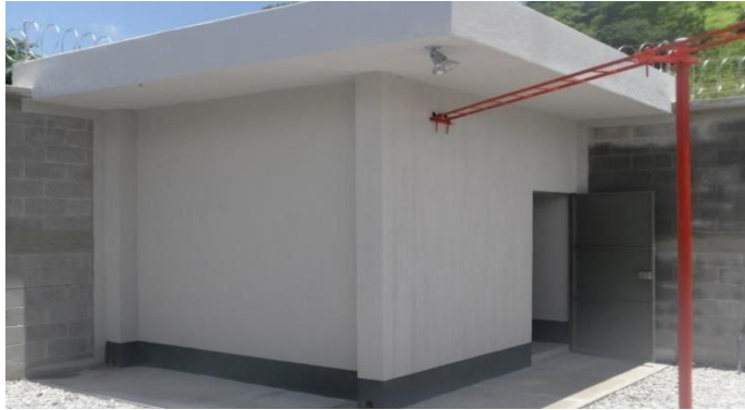
Figura 30. Pintura en caseta
