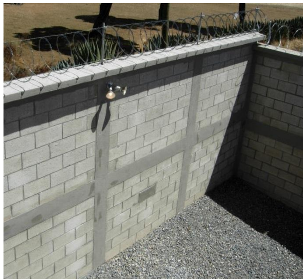
Figura 9. Muro de cerramiento con block
