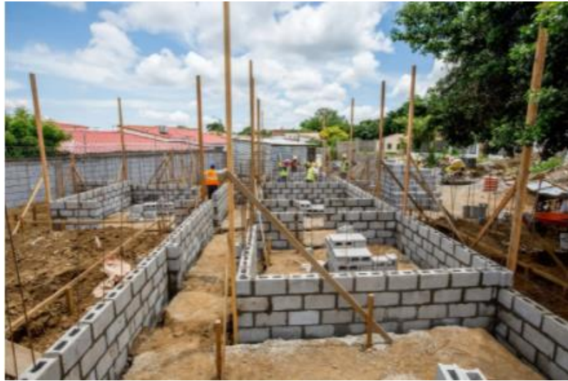
Figura 31. Construcción de muro de mampostería
