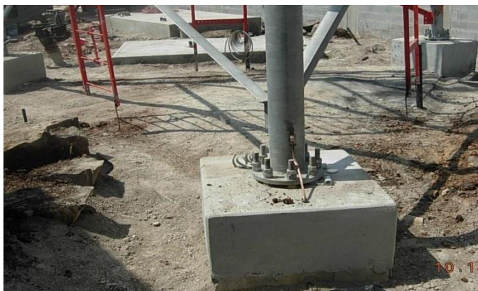
Figura 7. Concreto utilizado en la fundición de bases de torre
