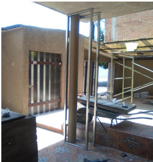
Figura 13. Cerramiento de mimetización tipo columna con durock
