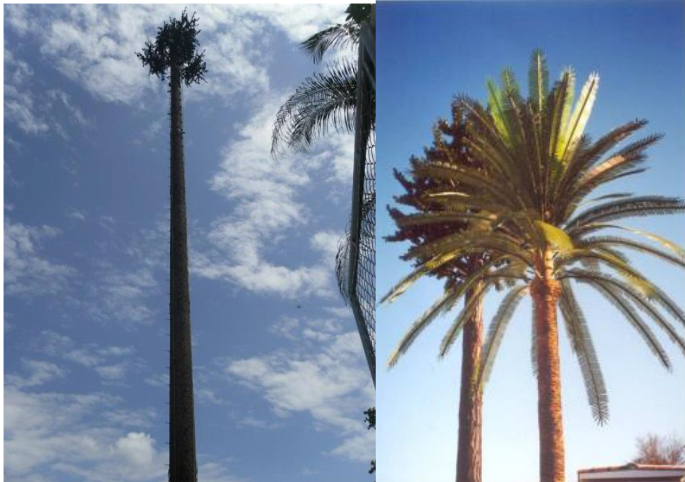
Figura 29. Mimetización de torre
