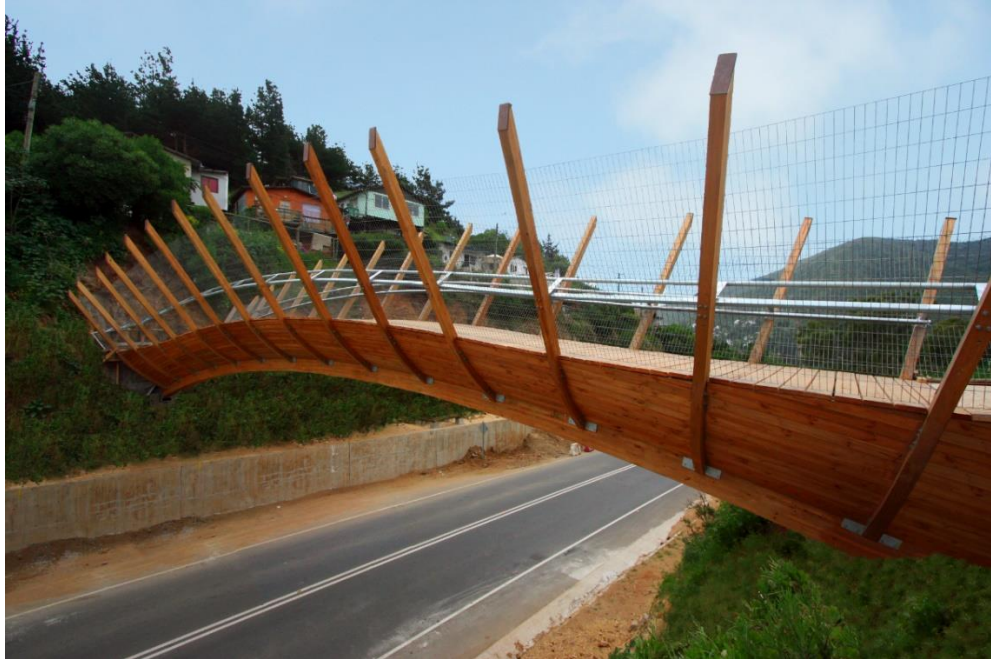
Figura 1. Puente peatonal en Zapallar
