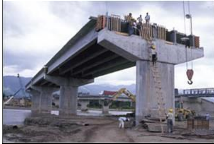
Figura 2. Puente Losa construido de vigas pretensadas
