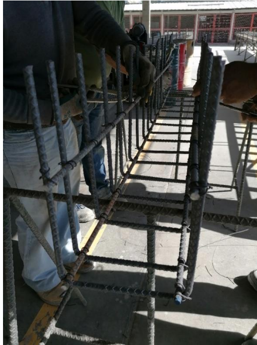
Figura 10. Armado de formaviga
