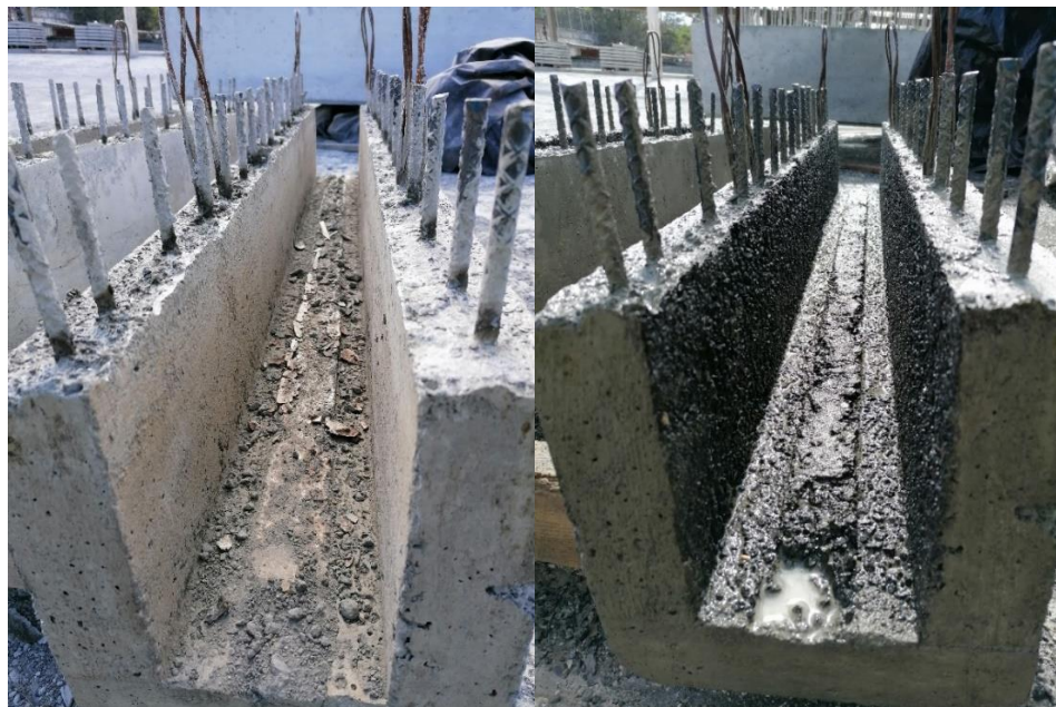
Figura 15. Formaviga desencofrada antes y después de lavar a presión (superficie interna rugosa)
