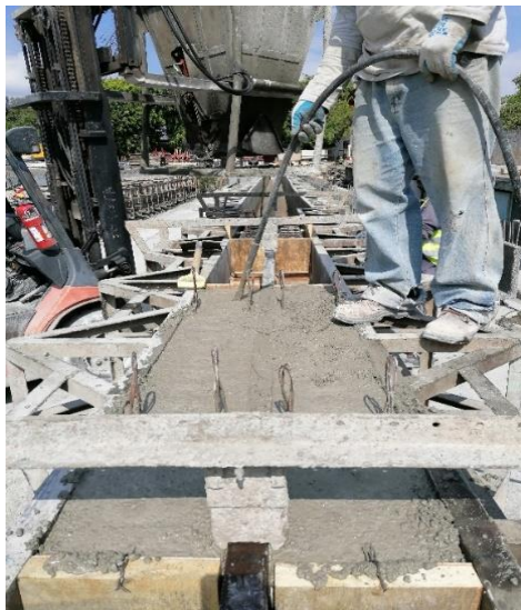
Figura 23. Fundición de vigas tradicionales
