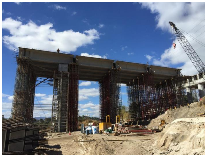
Figura 8. Instalación de segmentos de viga postensada en puente
