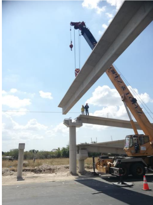
Figura 7. Instalación de viga pretensada
