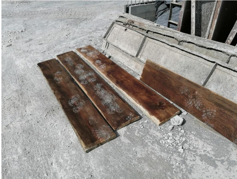
Figura 12. Moldura de formavigas
