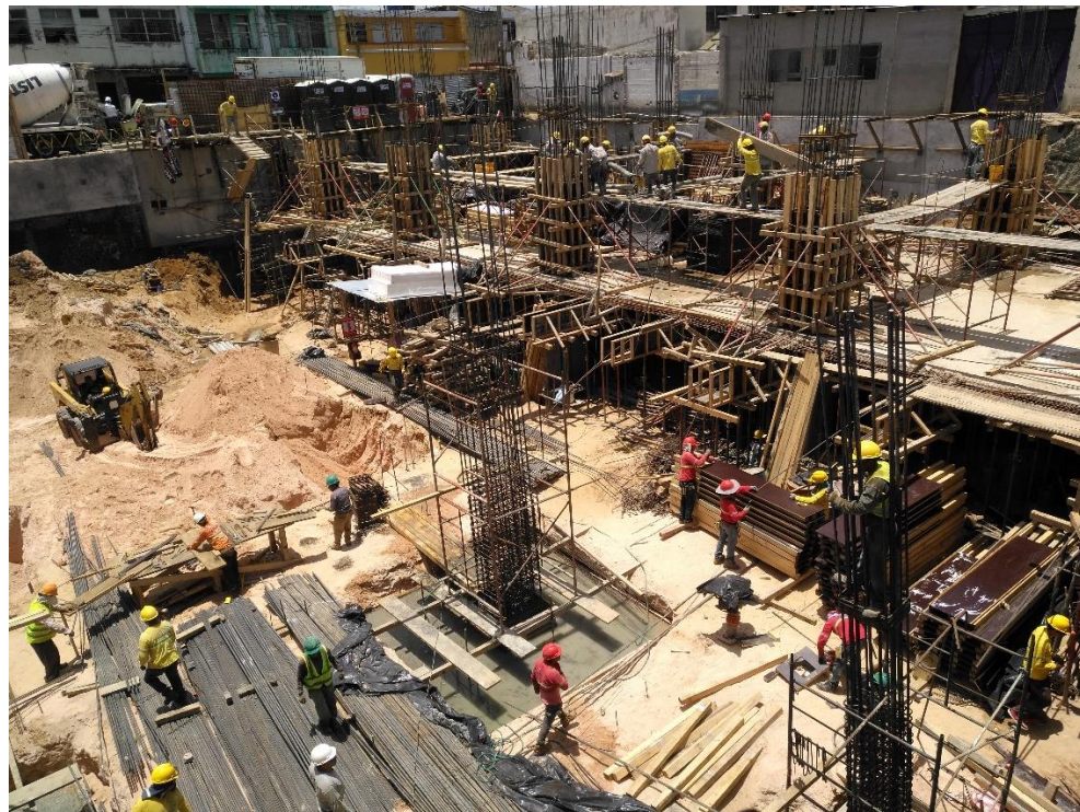
Figura 6. Encofrado y entarimado de elementos en obra
