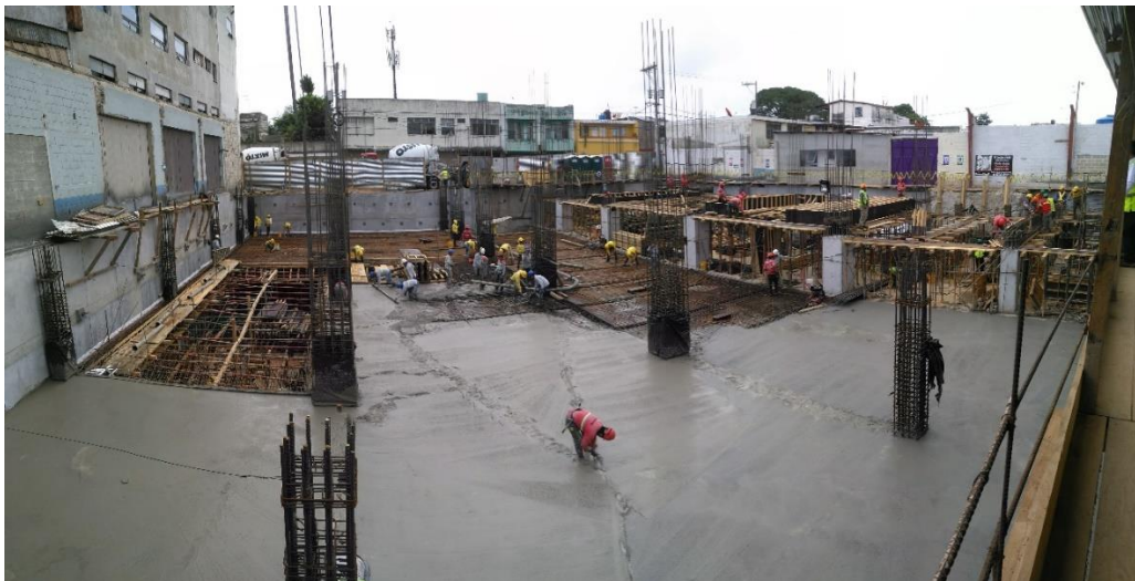
Figura 5. Fundición in situ de vigas y losa
