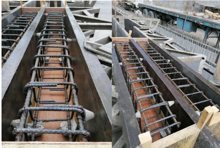
Figura 22. Colocación de armadura en molde
