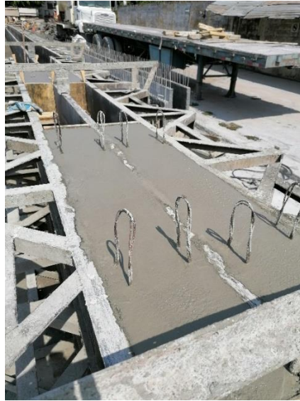
Figura 18. Formavigas fundidas
