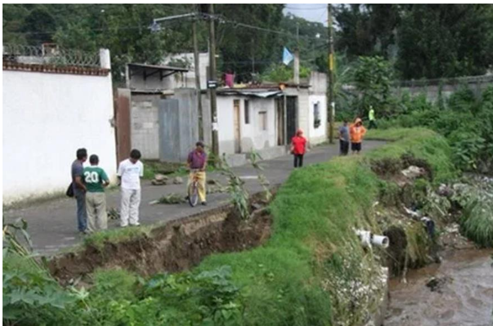
Figura 50. Inundaciones en Pastores
