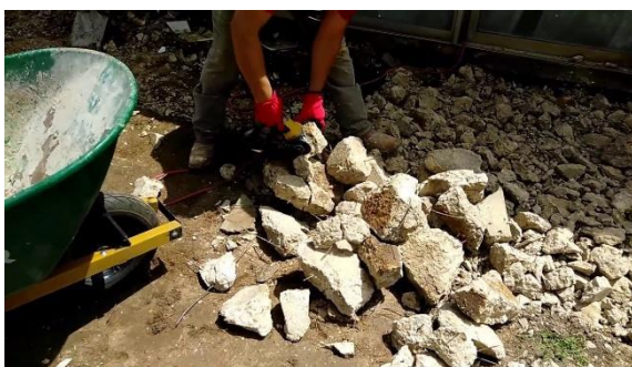
Figura 3. Trituración manual residuos de concreto
