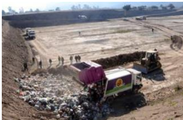
Figura 8. Relleno sanitario en operación (2)
