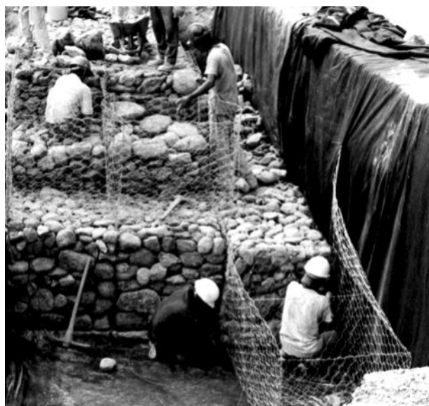
Figura 60. Empleo del geotextil
