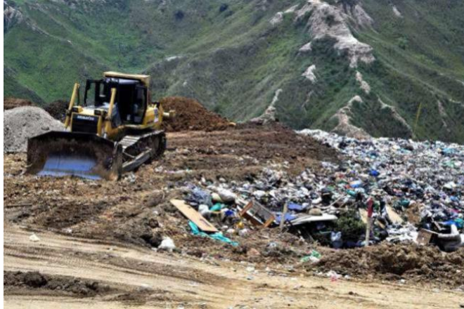
Figura 4. Compactación de residuos sólidos (2)
