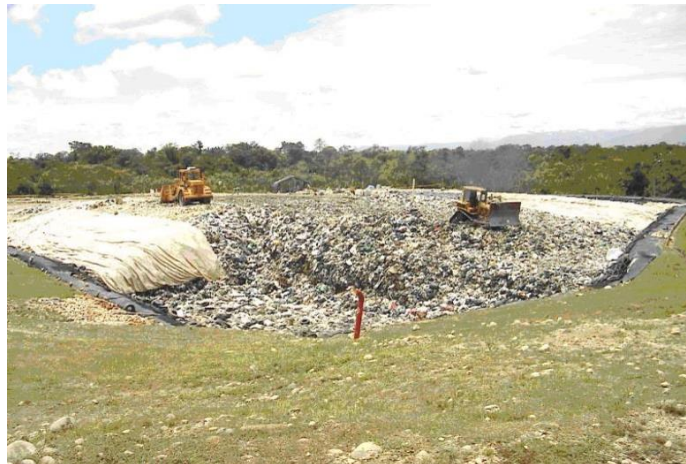
Figura 5. Compactación de residuos sólidos (3)
