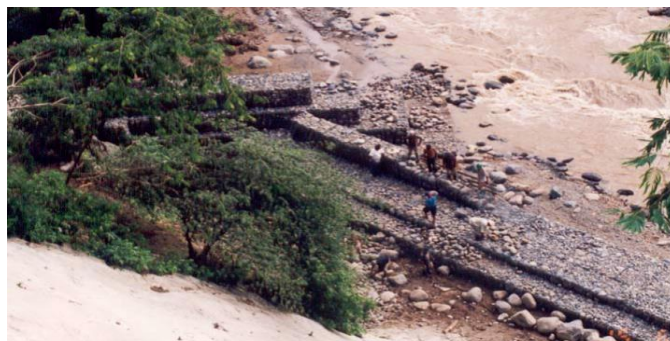
Figura 64. Muro con escalones internos formado con gaviones
