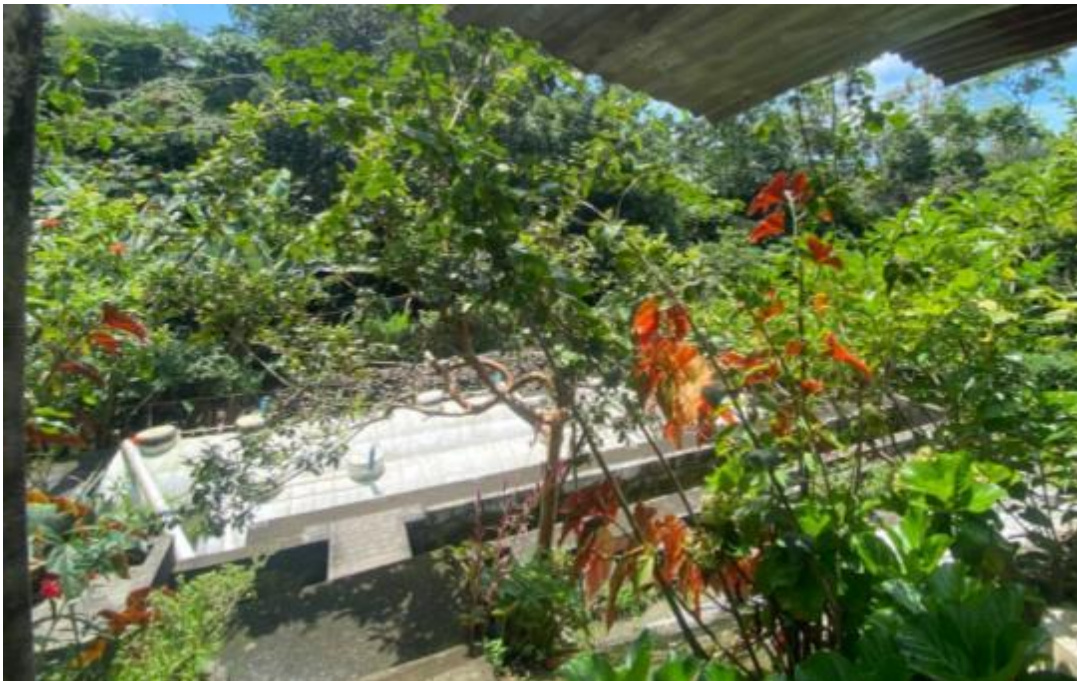
Figura 11. PTAR No. 1 aldea San Antonio
