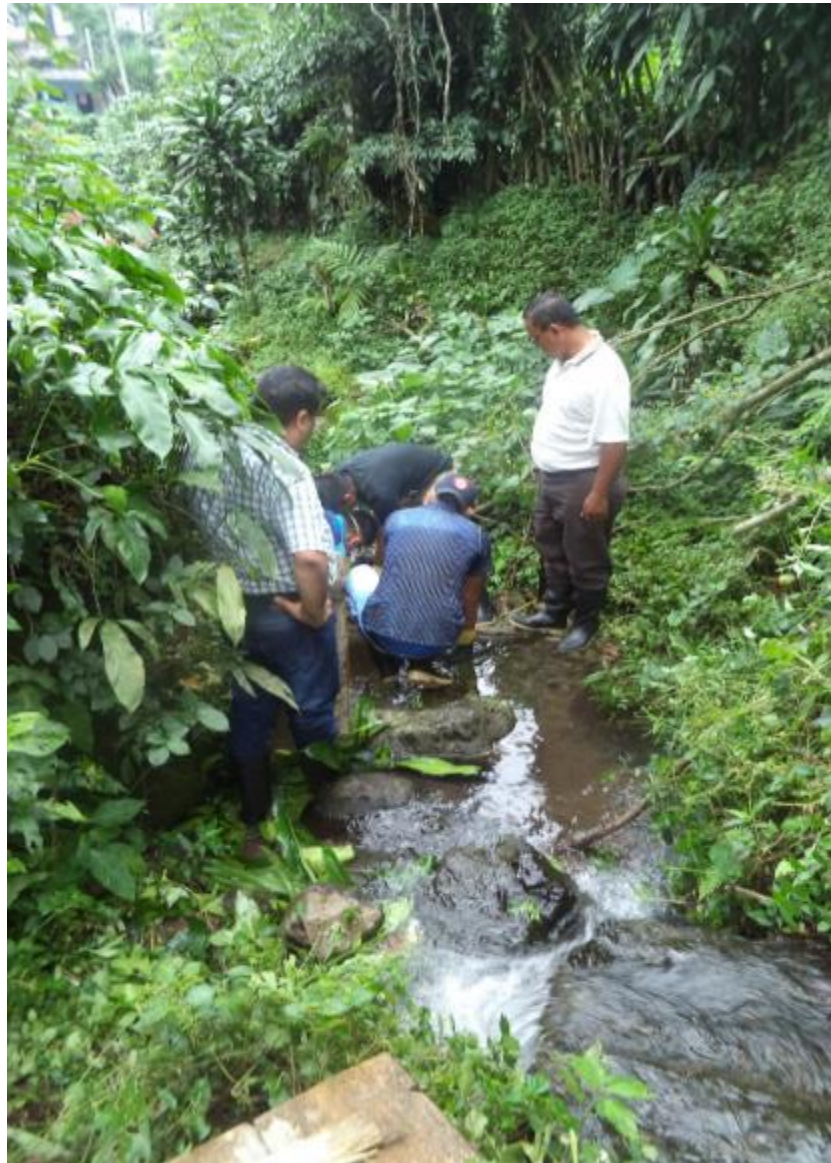
Figura 28. Punto de descarga de aguas residuales sin tratar de la aldea Mi Tierra
