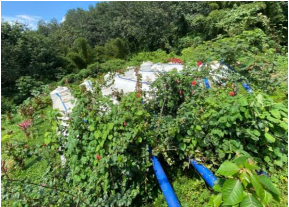
Figura 21. PTAR aldea Mi Tierra - Sector rastro municipal
