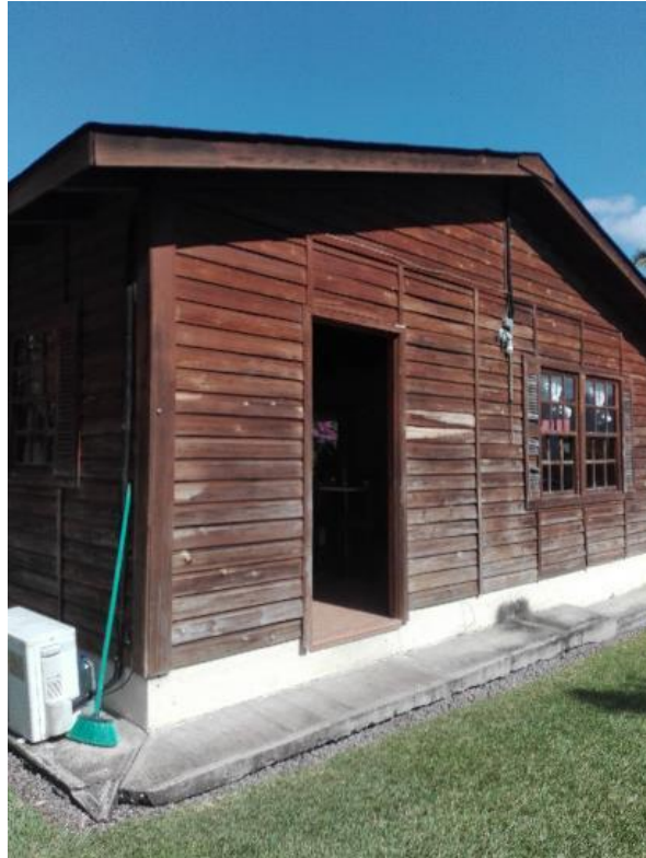
Figura 135. Casa en buen estado
