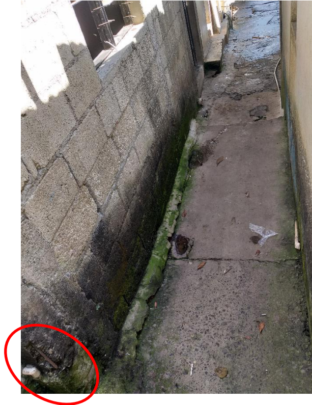
Figura 127. Muro húmedo
