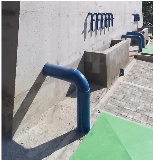
*Nota.* Se muestran las pilas para la toma de muestras de los lodos activados. Elaboración propia.
