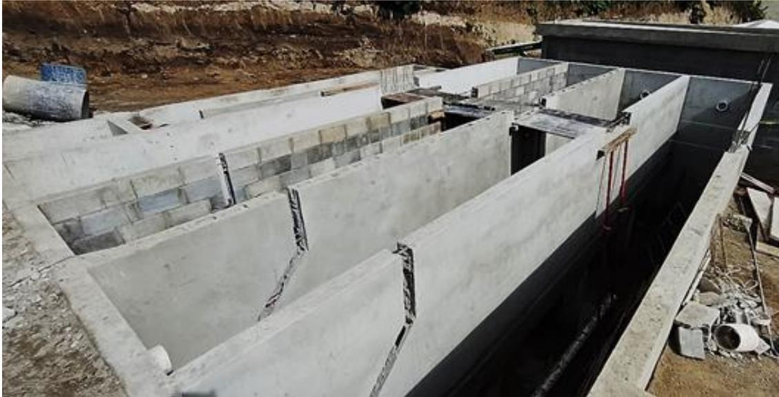
*Nota.* El tanque fue construido con muros perimetrales fundidos y sus muros internos con mampostería reforzada con ground. Elaboración propia.
