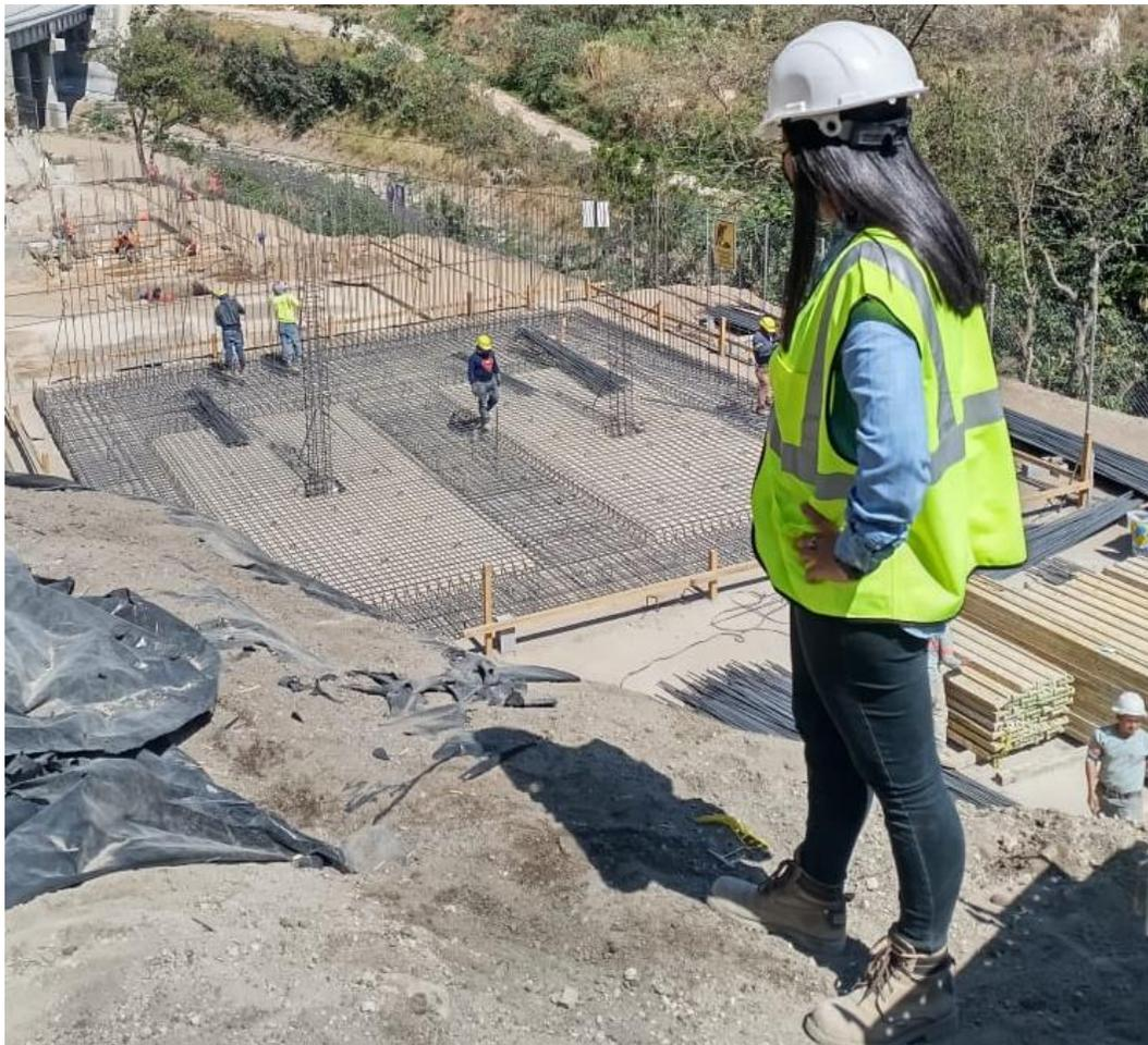
*Nota.* Para el refuerzo según el cálculo estructural se utilizaron barras No. 5 para la cimentación y barras No. 4 para el refuerzo de las paredes a doble cama. Elaboración propia.
