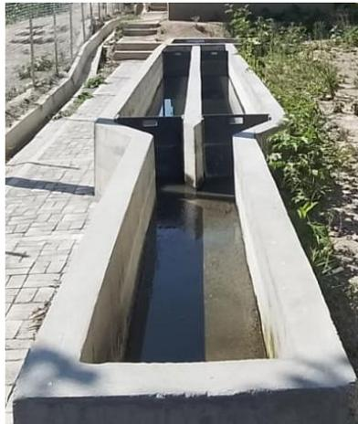
*Nota.* En esta fase las aguas residuales crudas ingresan y los sólidos más gruesos como arenas y basura quedan retenidos por sedimentación en las rejillas y los canales antes de llegar al tanque que alimentará al tanque de tratamiento primario. Elaboración propia.
