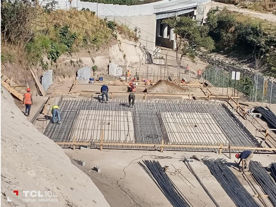
*Nota.* Las plataformas se impermeabilizaron con lodocreto con el fin de que el suelo al entrar en contacto con el concreto, este último no absorba humedad. Elaboración propia.
