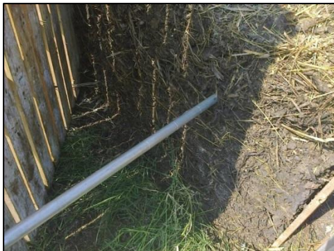
Figura No. 20 Perforación con tubos para muestreo
