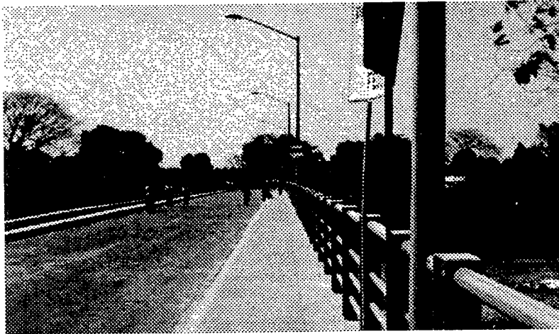
GRAFICA No. 6 VISTAS PANORAMICAS DEL PUENTE "Dr. Rodolfo Robles", sirve de límite entre Ciudad Hidalgo Chiapas México y Ciudad Tecún Umán Ayutla San Marcos y es utilizado como vía legal de paso.
