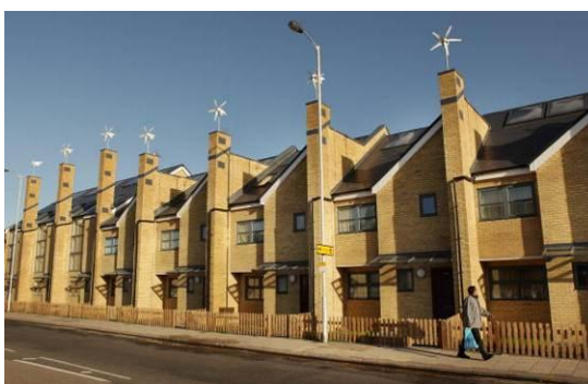
Ilustración 33 Instalación de aerogeneradores en parte más altas de las viviendas de un condominio en Croydon, Reino Unido. Imagen obtenida de http://energiacasa.wordpress.com/2009/12/27/eolica-imagenes-1/#more-855
