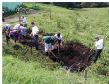
Excavación del sitio donde se colocará el biofiltro
