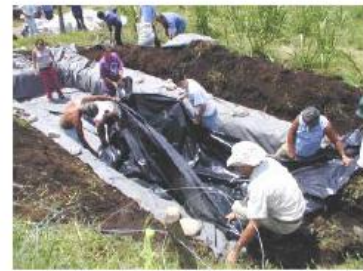
Colocación de materiales impermeabilizantes en fondo de
