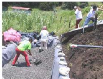
Colocación de materiales a utilizar como filtro
