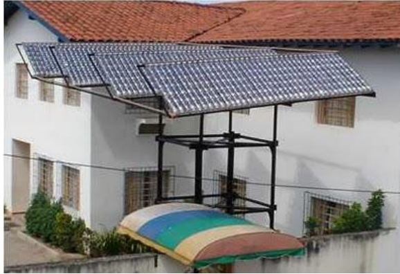
Ilustración 26 Termocolector fabricado a base de botellas de plástico. Imagen obtenida de http://parquehudson.blogspot.com
