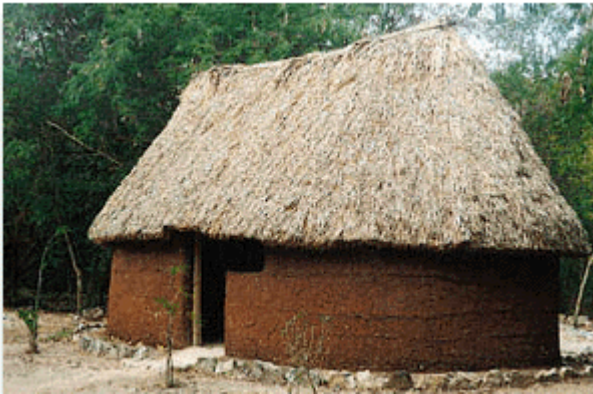
Ilustración 2 Vivienda Maya conserva una base rectangular en el centro y extremos semicirculares. Imagen obtenida de http://www.todoarquitectura.com
