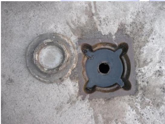
**Fotografía 70** tipo de drenaje tradicional en la zona 10 de Quetzaltenango. Se observa un tipo de reposadero en patio de concreto, mismos que comunican mediante a una red secundaria o domiciliar a una red principal.
