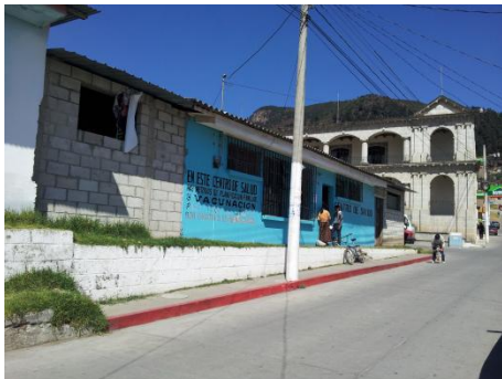
Fotografía 1. Fachada principal del estado actual CS Olintepeque. Fotografía propia.
