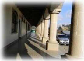
Fotografía 29. Edificio Municipal. Fotografía propia 2013.
