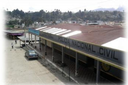
Fotografía 33. Instalaciones PNC. Fuente: Fotografía propia 2012.
