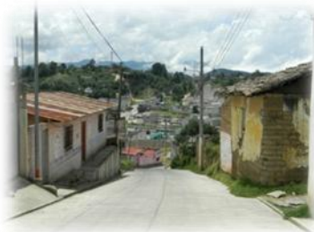
Fotografía 20. Viviendas formales de block con techo de lámina, y adobe con teja. Fuente: Fotografía propia 2013
