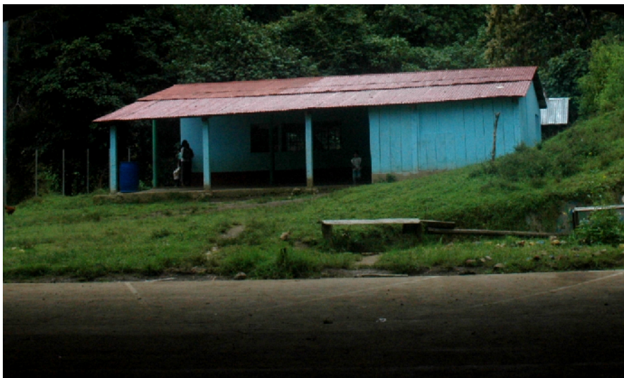
Escuela Primaria de El Desengaño, construida en 1973 y 1974
