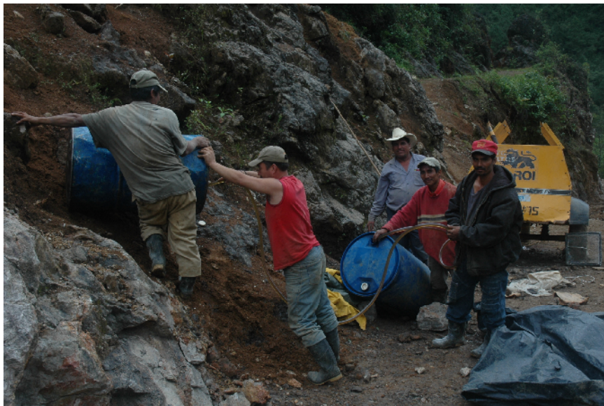
Trabajos en el camino que conecta El Desengaño con San Miguel Uspantán
