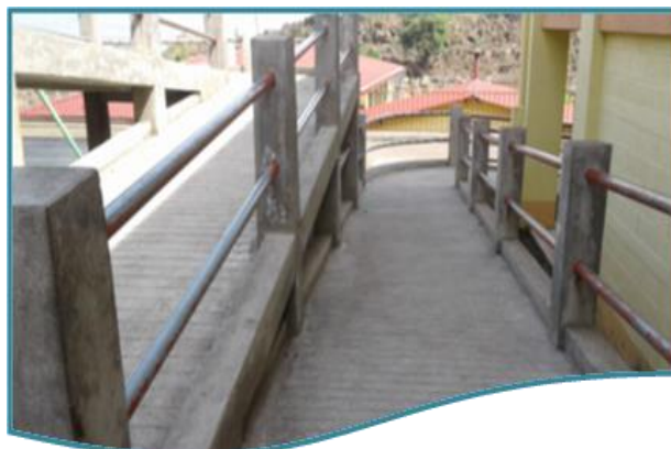
Fotografía No. 1 por la entrevistadora: Rampa Escuela de Chukumuk, Santiago Atitlán.
