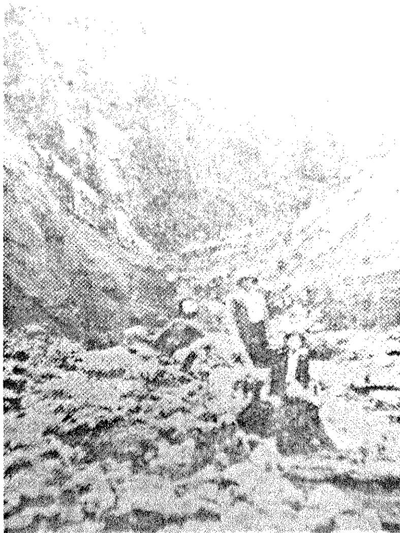
"Vista completa del lavado en la misma línea; arriba se ve como un puente colgante o como el esqueleto de un animal antediluviano, los durmientes y los rieles; la corriente, socavó el terraplén mal dispuesto y pésimamente construído; el punto blanco que se advierte es la perforación de un desagüe"1
