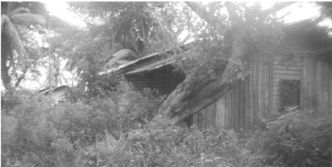
Sucesión de casas abandonadas por los mozos de rancherías, casi cubiertas por vegetación.
