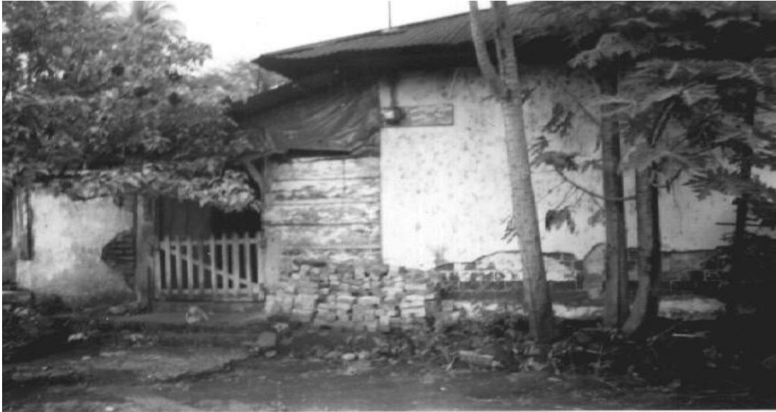
Casa de caporal o mayordomo, hecha de ladrillo, madera y láminas. En el frente de la casa se puede observar un árbol de achiote.
