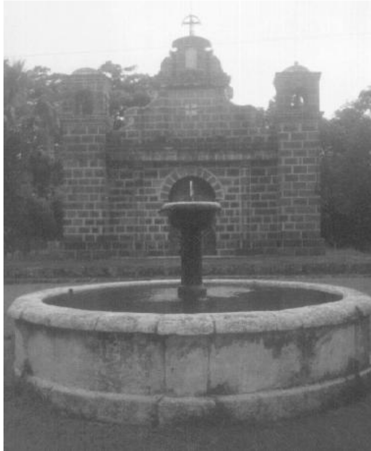
Iglesia, campanario y fuente, contruidos en el casco de la ranchería de una finca que ahora está deshabitada.
