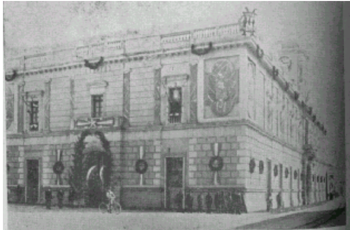
El mismo edificio de Correos, reformado en 1908, y destruido parcialmente por los terremotos de 1917-1918. Fotografía tomada de la misma fuente.
