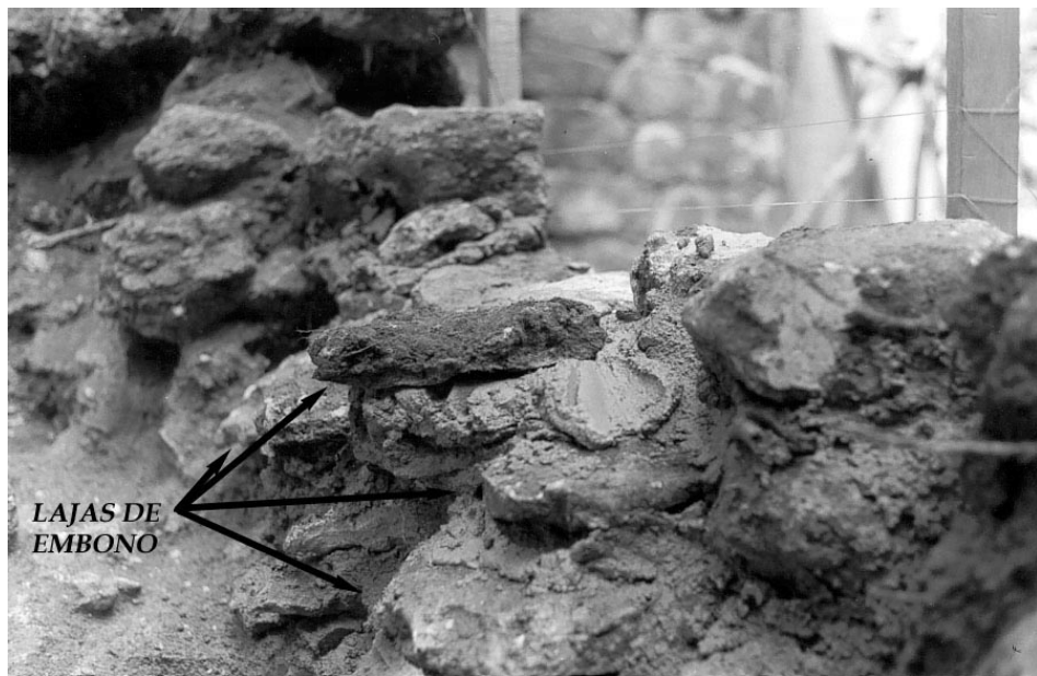
Foto 9: Embono preparado con lajas, estructura 6F - 9 del Grupo Guacamaya.
