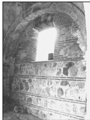
Vista interior muro Oriente Sector Sur intervenido por el -CNPAG-
