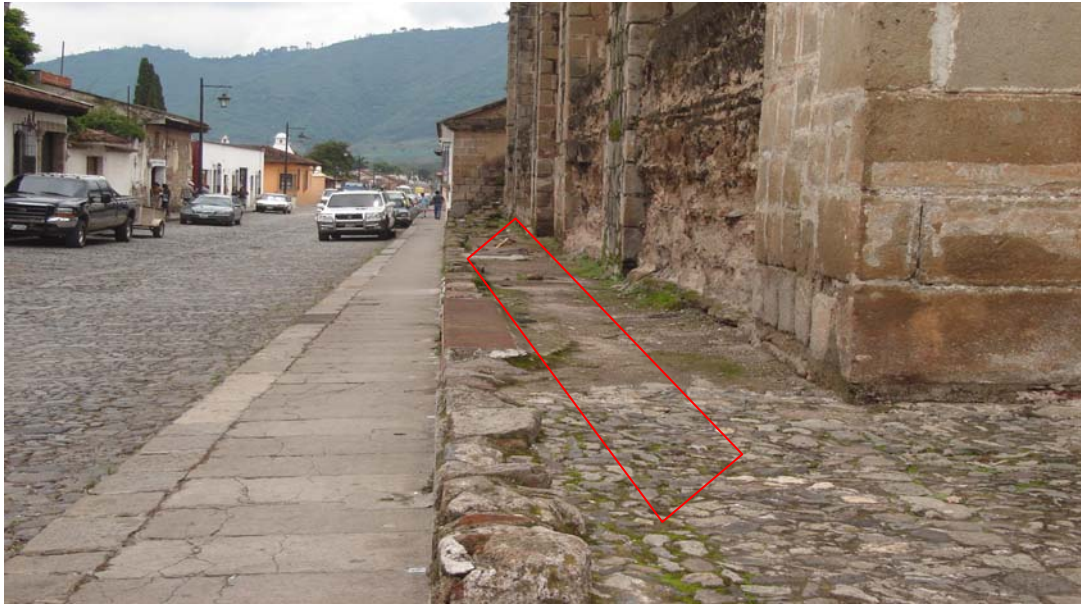
Foto 22: Vista total del antiguo muro del Colegio de Nuestra Señora de la Presentación mejor conocido como niñado, los cuales colapsaron en 1717 para el terremoto de San Miguel.
