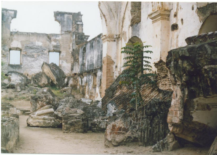
Foto 6: Vista del interior de la nave principal del Convento de la Concepción, nótese el estado actual del monumento.
