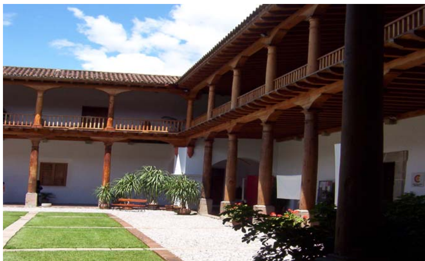
Foto 32: El Claustro sur oriental, muestra la construcción de artesón que fue restaurada a finales en su versión del siglo XVIII y remozada a finales del siglo XX.
