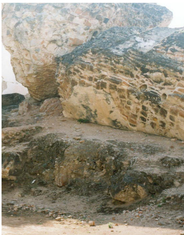
Foto 10: En esta toma puede observarse la cantidad de ripio que existe en el interior del Convento de la Recolección.
