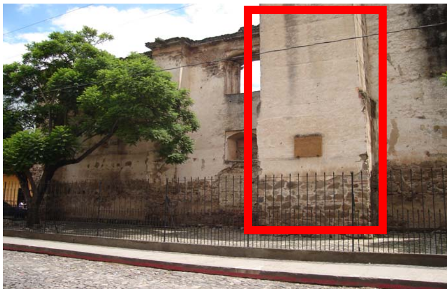
Foto 33: En esta fotografía se observa un contrafuerte construido después del terremoto de San Miguel en 1717 para reforzar el edificio, puede verse ventanales rellenos que indican que se hizo sobre una construcción anterior.
