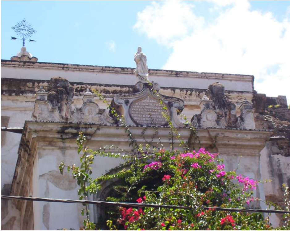
Foto 28: En esta fotografía puede observarse un camarín construido en 1747, única construcción que data de esa época.
