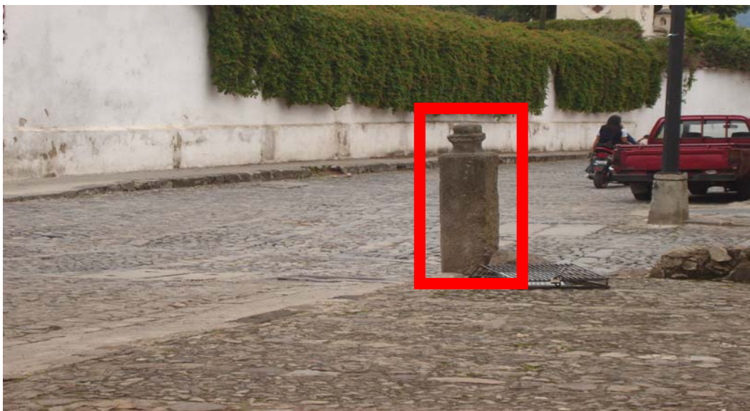
Foto 24: En esta fotografía se encuentra este guarda cantón que hacia escuadra con el muro anteriormente señalado, que componía el niñoado.
