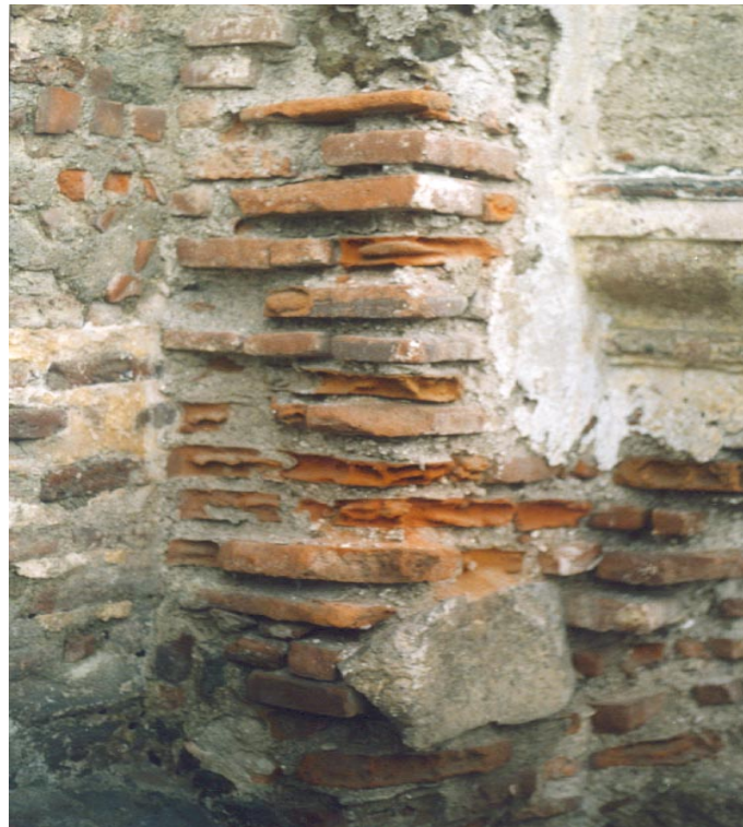
Foto 8: Toma que muestra una consolidación en una de las columnas del Templo.
