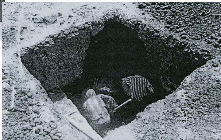
Fotografía No. 7 Excavación de botellón 4 Piedra Parada. (Tomado de de León, 2000)
