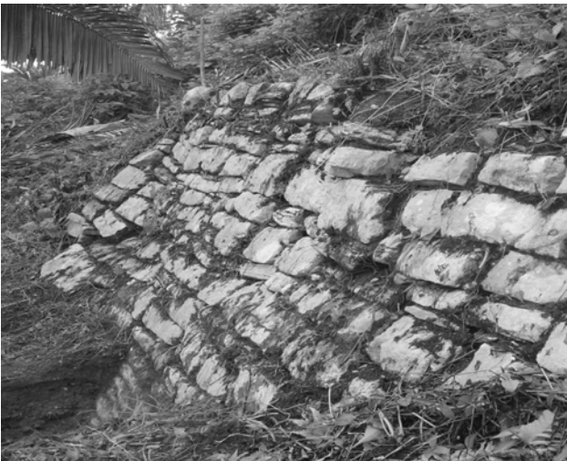
Fig. 24 Fotografía de Muro 3
