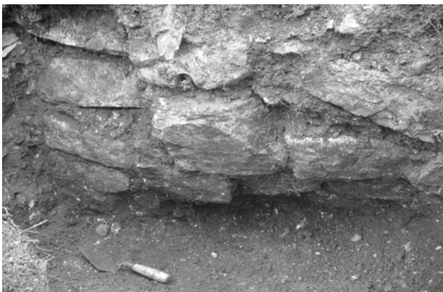
Fig. 22 Fotografía de Muro 1
