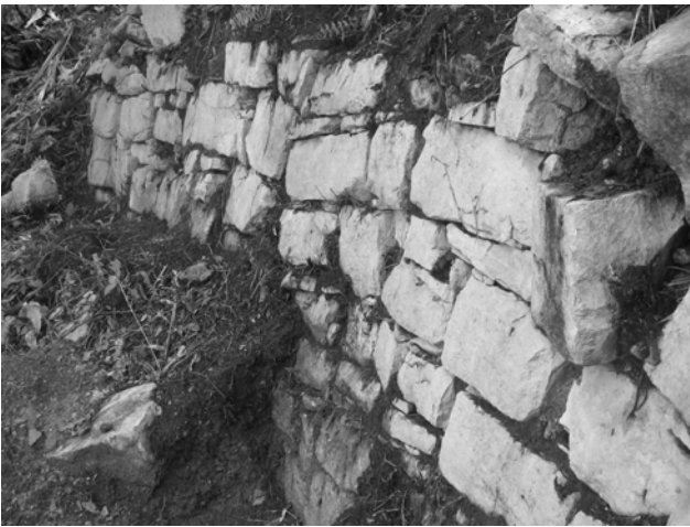
Fig. 27 Fotografía de Muro 6
