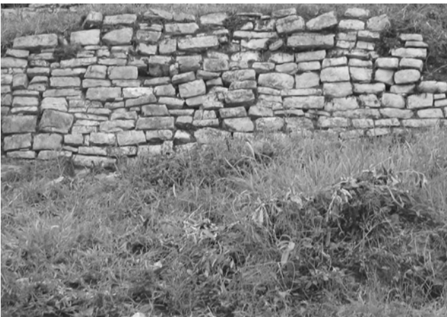
Fig. 25 Fotografía de Muro 4
