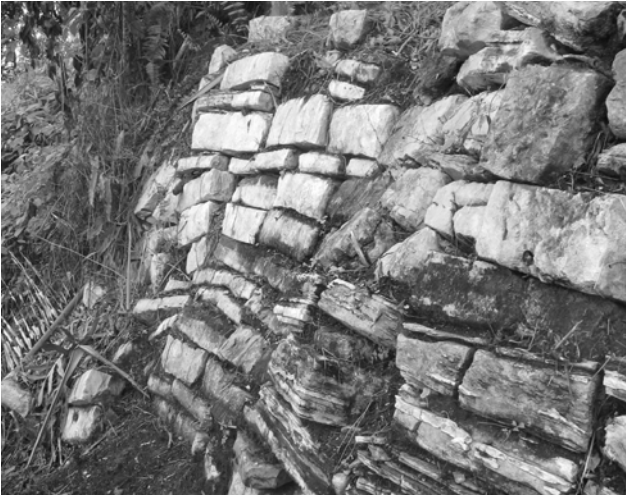
Fig. 26 Fotografía de Muro 5
