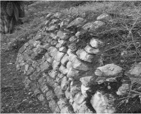
Fig. 23 Fotografía de Muro 2
