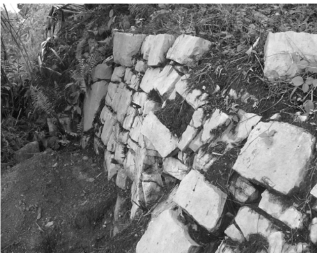
Fig. 28 Fotografía de Muro 7
