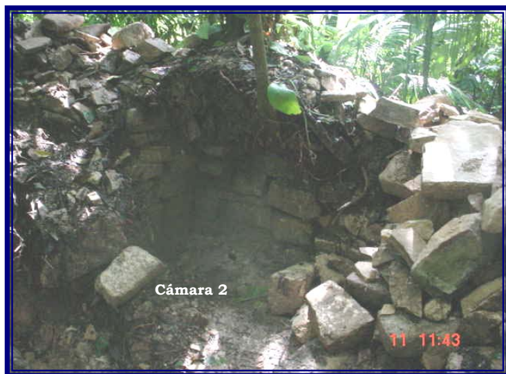
Fig. 23 – Muro interior de la Cámara 2 (este) de la Estructura B8.
