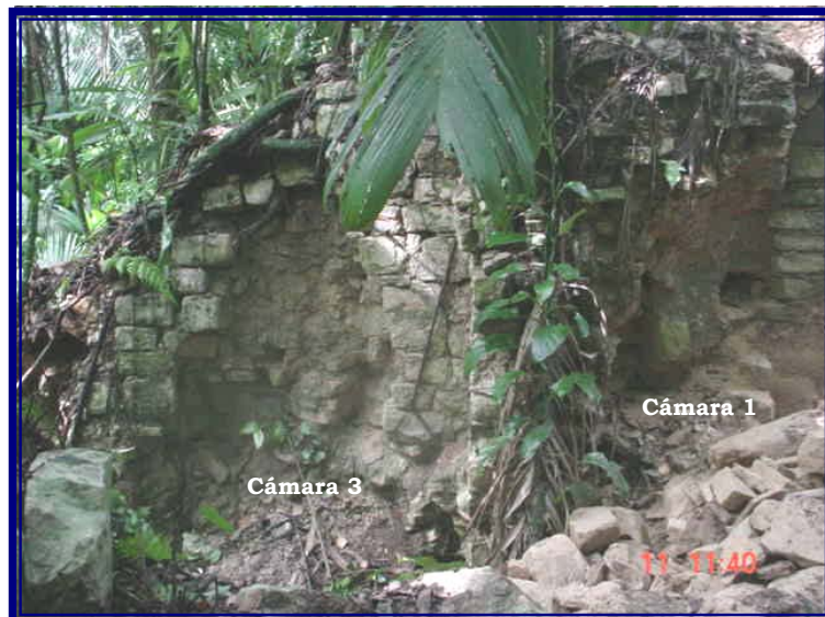
Fig. 24 – Muro interior de las Cámaras 1 y 3 de la Estructura B8.
