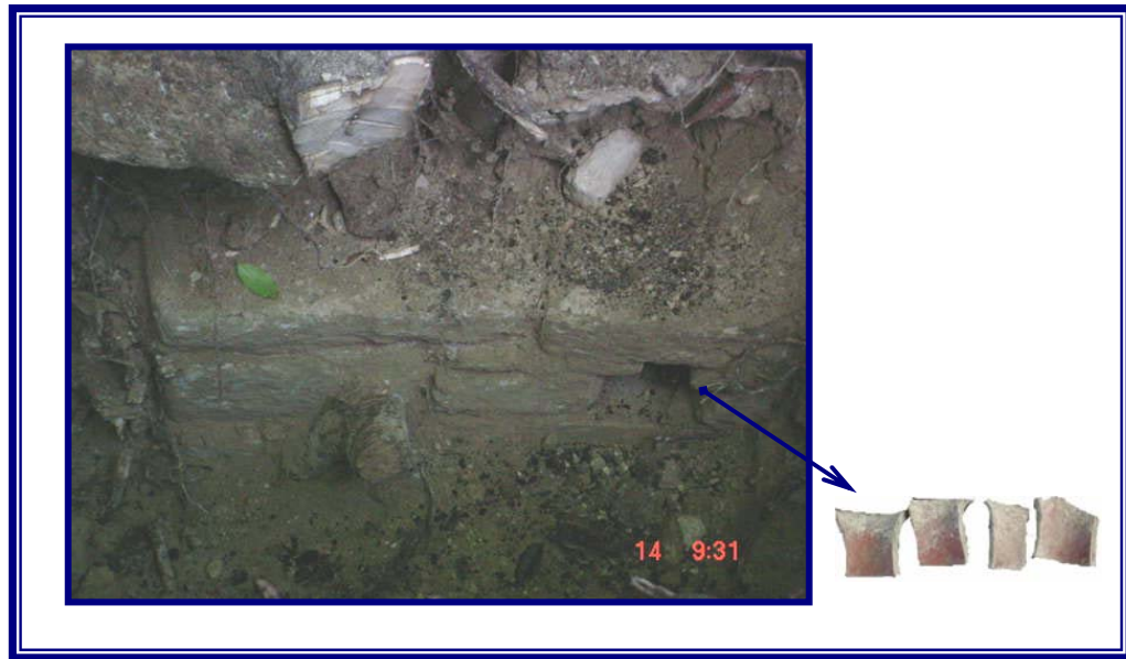
Fig. 57 – Cortinero o sujetador localizado en muro norte de puerta de acceso de la Cámara 2 en Estructura B7.
