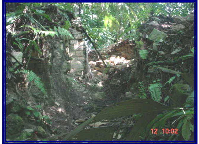
Fig. 11 – Lado sur de estructura B8, frente a cámaras 2 y 3, mostrando su alto grado de destrucción.
