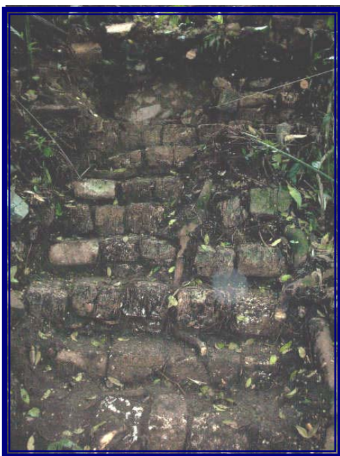
Fig. 21 – Escalinata norte de Estructura B7, remodelándola a una plataforma alargada sellando los cuartos. Tercera etapa constructiva del palacio.
