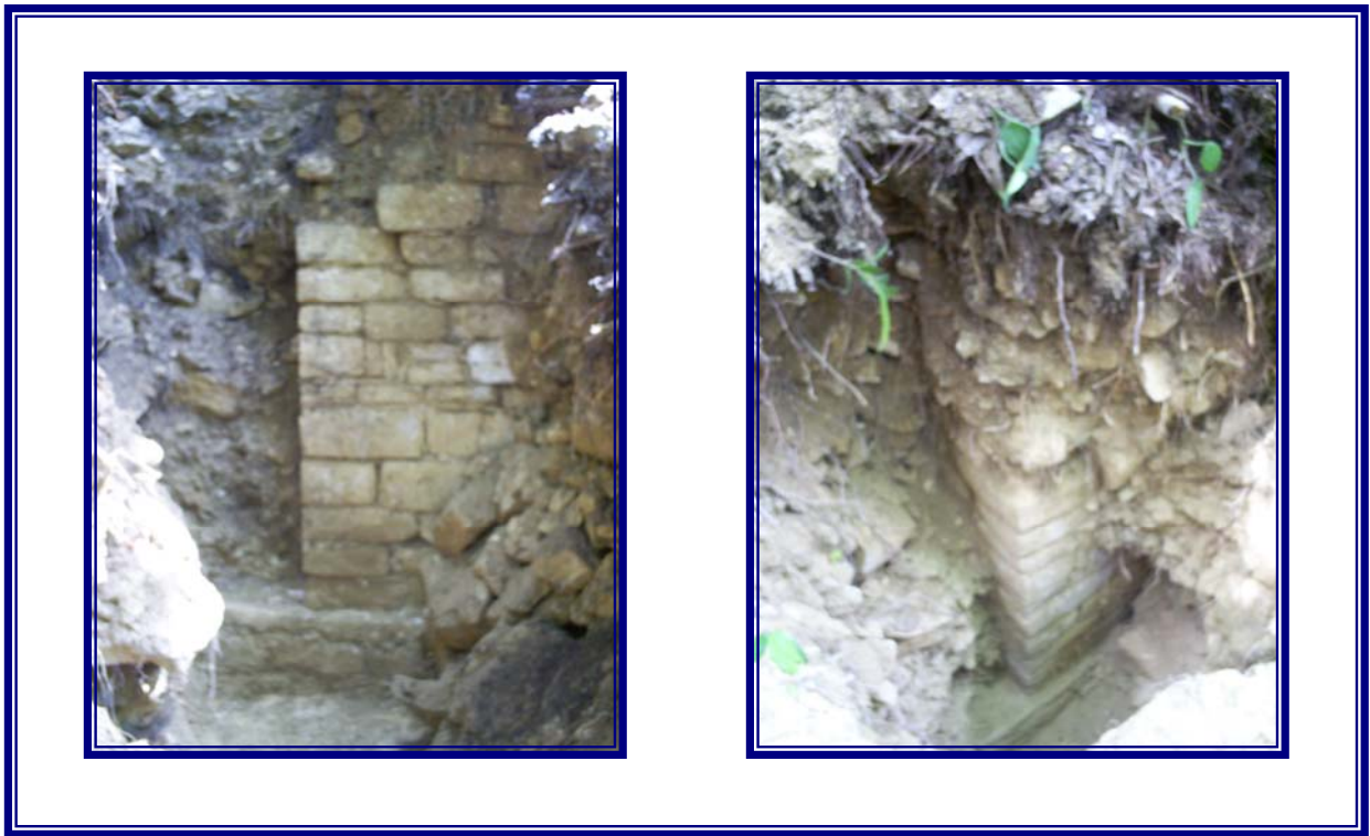
Fig. 18 – Jambas de cuartos abovedados de fachada sur de Estructura B7.
