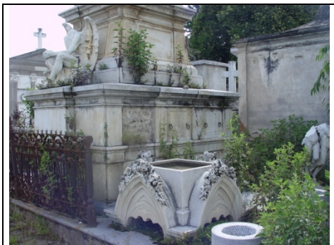
Tumba en completo deterioro y abandono
