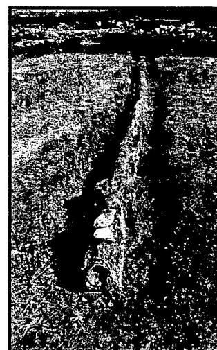
Foto. 3 Cañería con protección de tejas
