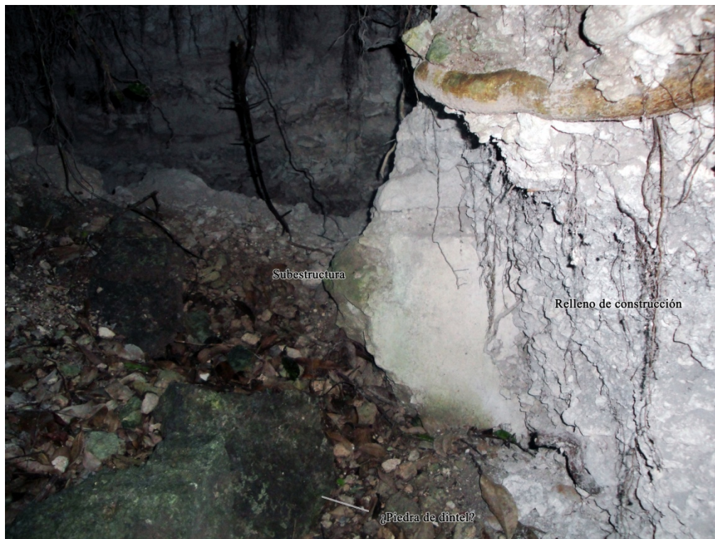
Figura 4.36 Impresionante túnel de saqueo en la Estructura 2A11-1 que expone una subestructura (Foto: C. Morales-Aguilar).
