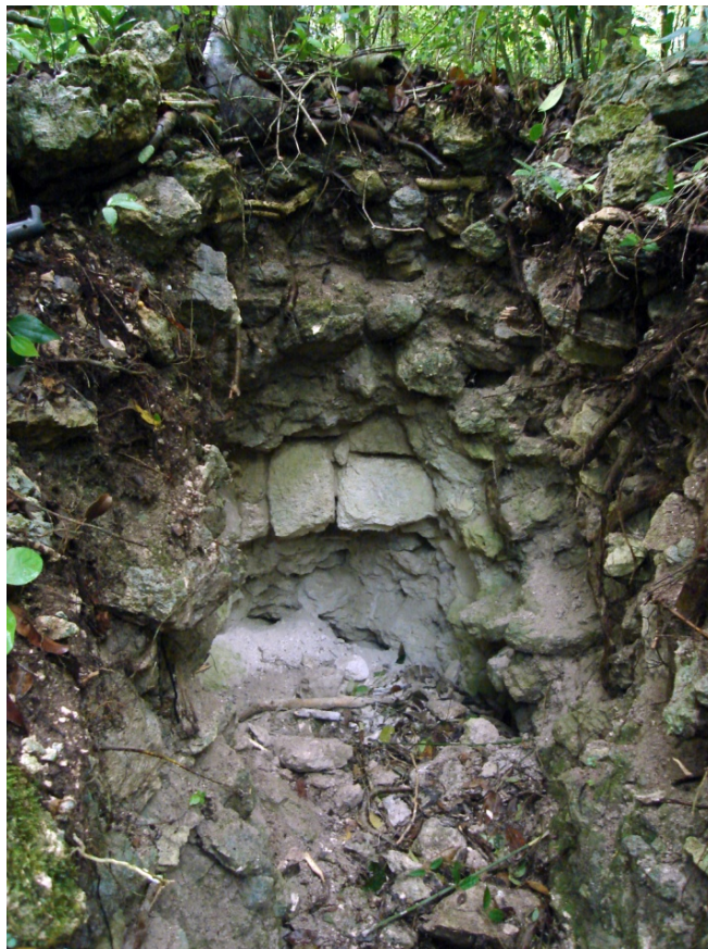
Figura 4.17 Túnel de saqueo en la Estructura 3A8-8, Grupo Barba Amarilla (Foto: C. Morales-Aguilar).
