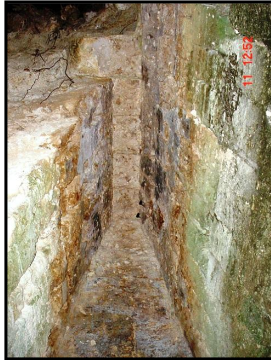
Figura 19. Detalle interior de bóveda casi Intacta del Cuarto 5, Edificio 6J2. Valladares, 2009.
