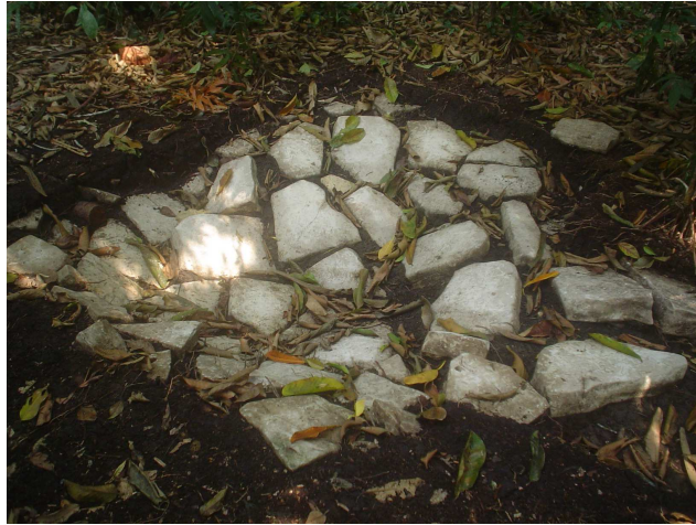
Anexo 2.1 Piso de lajas alrededor del Reservorio Norte, el hundimiento se debe a las raíces de arboles (Fotografía S. Alvarado 2007)
