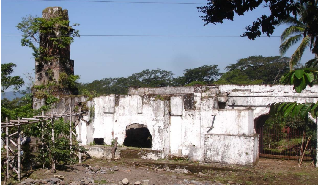
Parte posterior de los acueductos A y B de Medio Monte que muestran es estado actual de ambos como también de la chimenea
