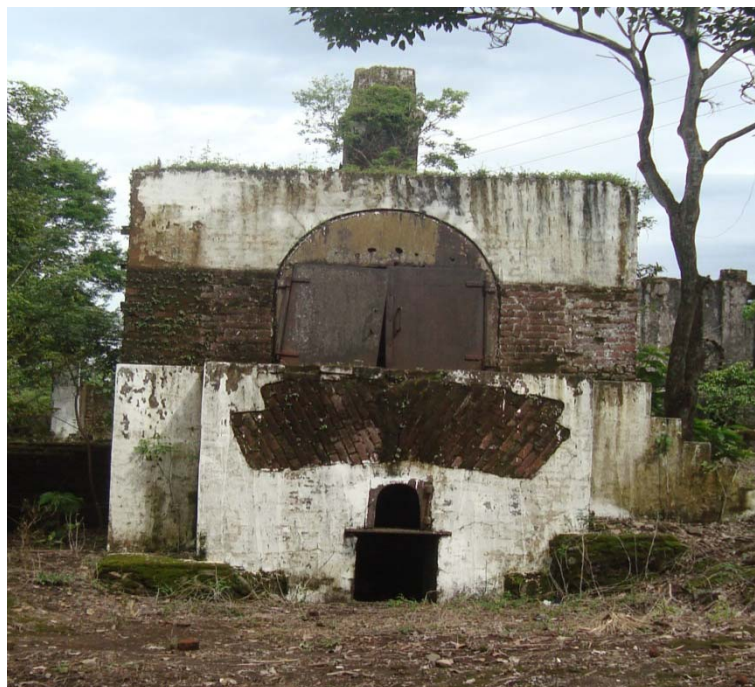
Fotografía de la caldera que da cuenta del estado de conservación en el que se encuentra en la actualidad.
