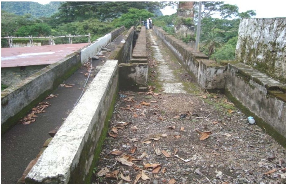
Fotografía que muestra la parte de la estructura de los acueductos A y B.
