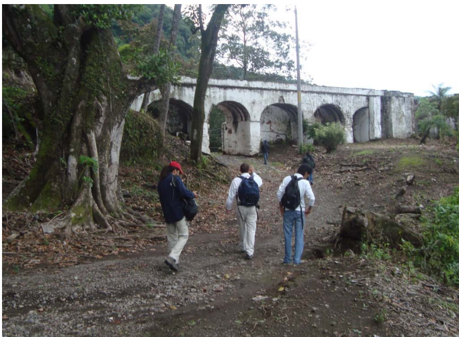
Entrada actual de la finca Medio Monte donde se observa la parte central de los acueductos
