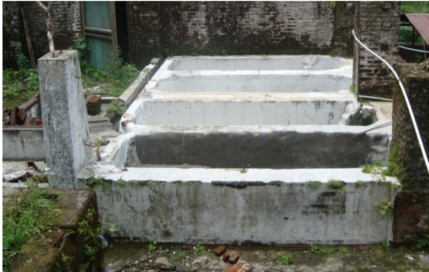
Fotografía que muestra parte del subsistema de fermentación en su estado actual de conservación en Medio Monte.
