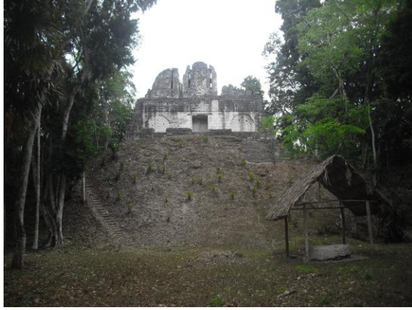
Fotografía 45. Edificio A, Plaza Central.
