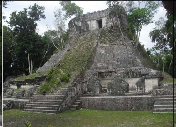
Fotografía 44. Edificio E, Patio 1.
