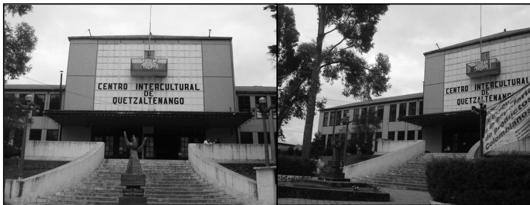
Figura 7. Actual estado de la fachada sur (Fotografió MB. Méndez 2008).
