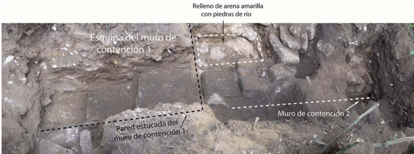
Foto 6: base de muro de contención de la Plataforma N-B (JM. Palomo 2007)
