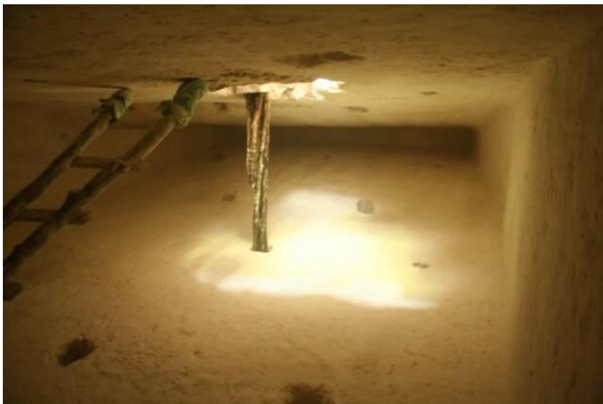
Figura No. 50, Cresterías Vacías o Aligerantes de Peso. Vista del Interior de la cámara 1, del primer nivel, de la crestería del Templo IV. Imagen tomada por Miguel Acosta 2007.
