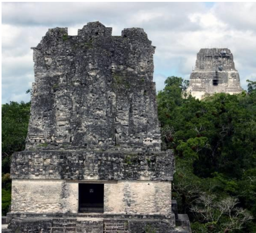
Figura No. 10, Arquitectura y Cresterías Tipo Petén. Fachada principal Crestería Templo II y IV de Tikal. Imagen tomada el 11 de septiembre, 2006.
