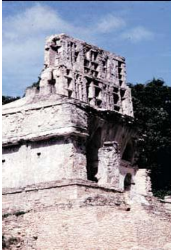
Figura No. 11, Arquitectura y Cresterías Tipo Palenque. Templo de la Cruz, Palenque. Chiapas. Tomado de Tesis Doctoral Arquitectura Maya "Templo I de Tikal" 2003. Pág. 165.
