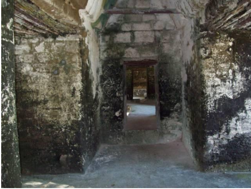
Figura No. 72, Edificio 5D-91. Imagen mostrando los muros gruesos agregados y adosados como soporte en el interior de las cámaras. Tomada el 21/01/10.
