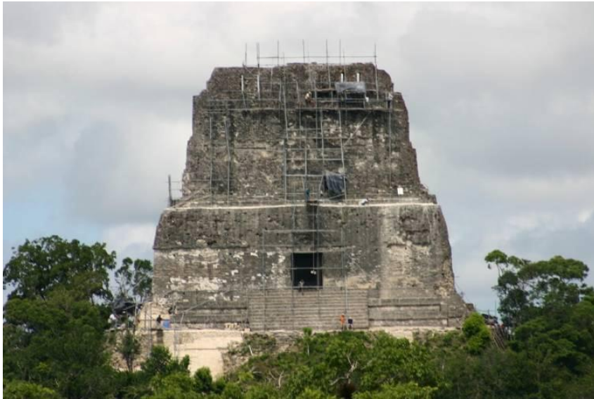
Figura No. 47, Elemento Estructural. Fachada Principal Templo IV, de Tikal. Imagen tomada 2007.
