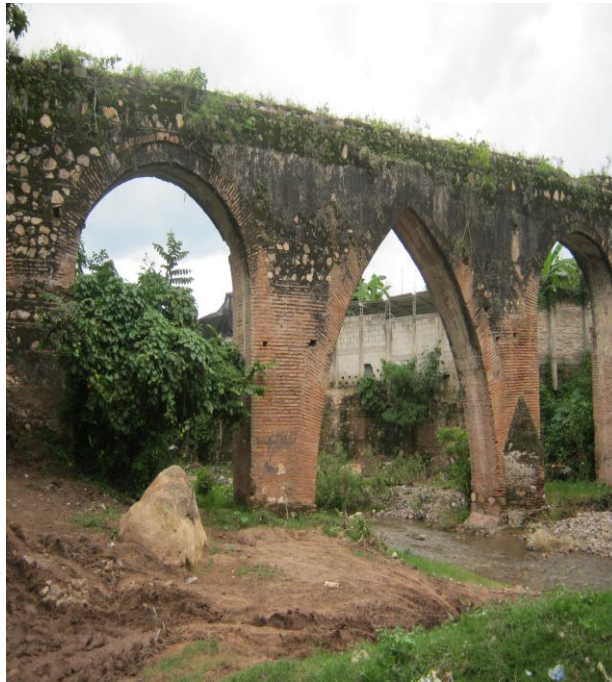
Acueducto de Esquipulas. Aldea Belén, Rio de los Arcos. Esquipulas julio, 20011
