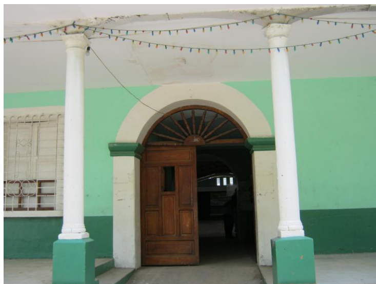
Edificio antiguo de la Municipalidad. Esquipulas, julio, 2011
