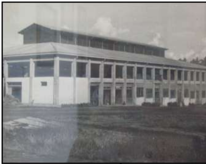
Se puede observar la imponencia del almacén azucarero con que contaba la Hacienda Bárcena. Actualmente, sólo se encuentran las columnas que sostenían dicha estructura.
