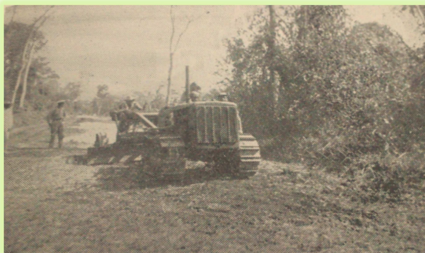
Figura 4. Trabajo de desmonte de la carretera Flores-Dolores-Poptún Tomada de Soza 1957.
