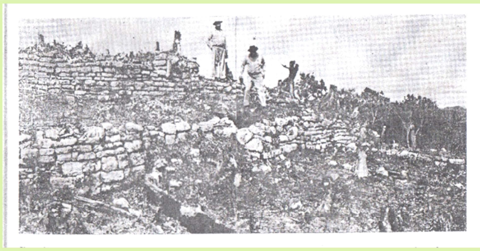
Figura 14. Detalle de la sillería en las paredes de la terraza (abajo) y de las plataformas sub-estructurales (arriba). Grupo Norte, Poptún/Tomado de Shook y Smith 1950.
