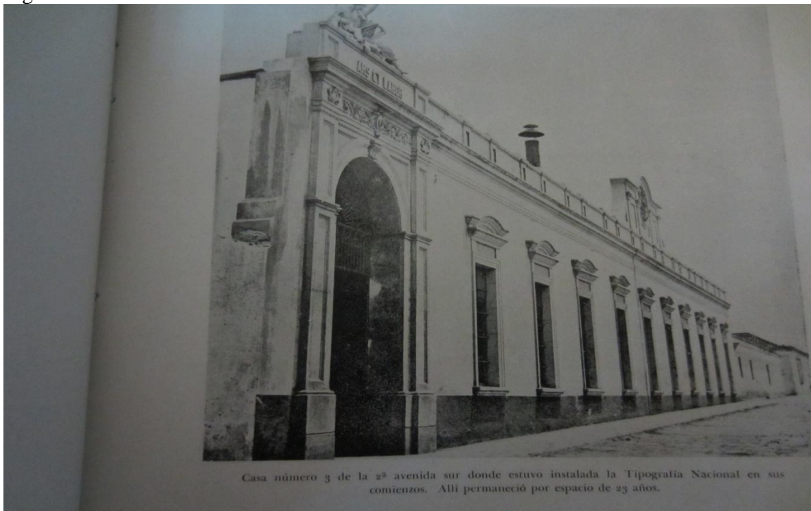
Fuente: Fotografía de la fachada del primer edificio de la Tipografía Nacional, publicada en la Revista conmemorativa: "Cincuenta Años de la Tipografía Nacional de Guatemala, 1894-1944, 7 de enero", que se encuentra en la Biblioteca de la Tipografía Nacional. (fotografía tomada por Thelma Mayen)
