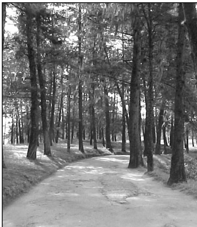
Fotografía No. 6. Bosque que cubre el sitio y ha dañado varias estructuras (archivo proyecto Q'um'arkaj).
