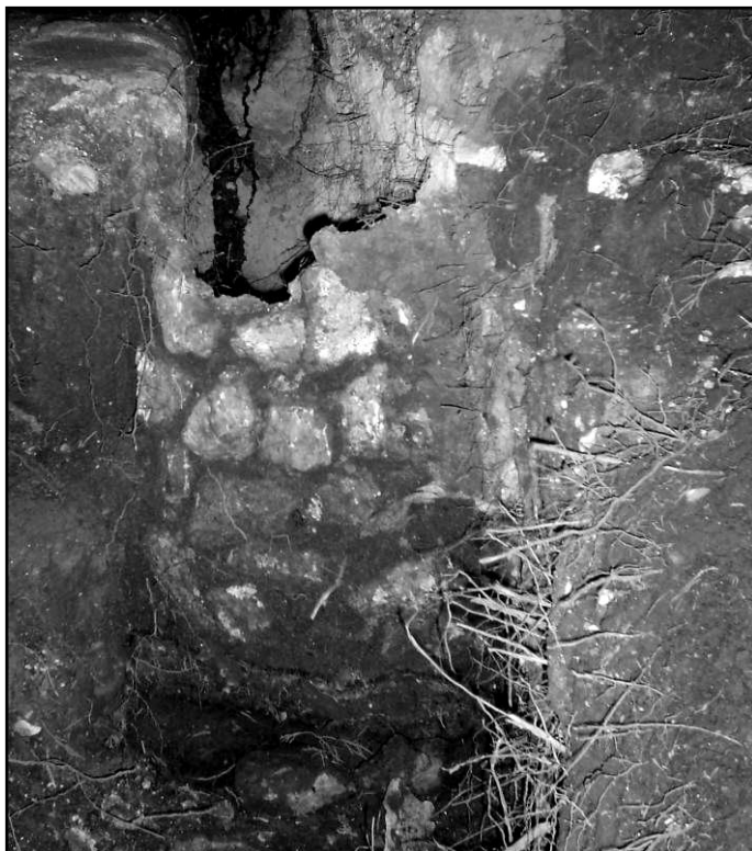
Fotografía No. 35. Detalle del sistema constructivo del depósito estucado, y utilización de bloques pómez (archivo Proyecto Q'um'arkaj).
