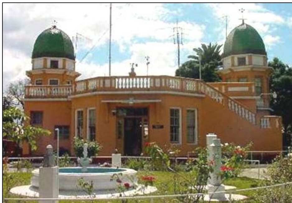
Figura 5.18 Edificio del INSIVUMEH (Tomado de www.insivumeh.gob.gt INSIVUMEH ©2014).
