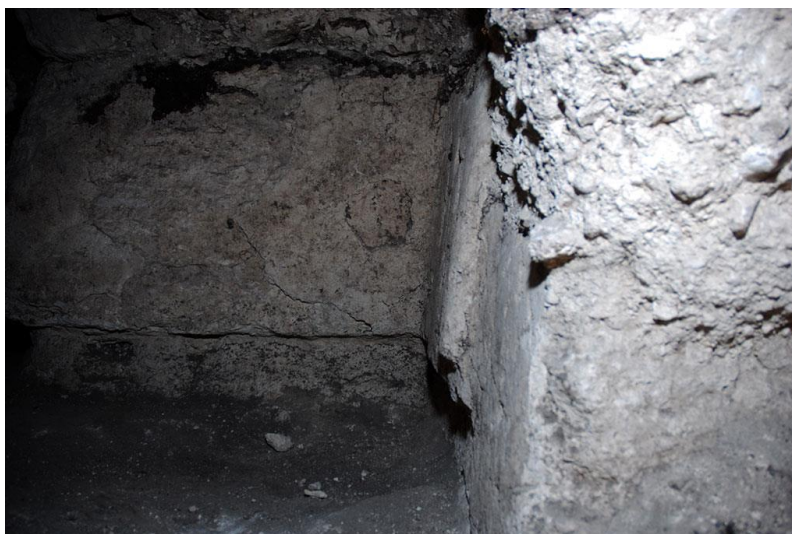
Figura 63. Fotografía del muro entrante y saliente en esquina sur-este (fotografía de Boris Beltrán).
