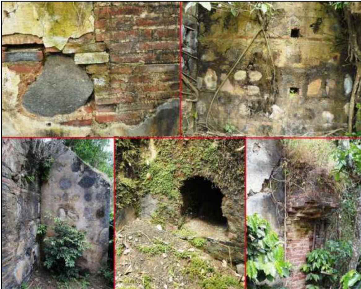
Figura 39: Aspectos constructivos de las ruinas, se destaca el tipo de materiales constructivos utilizados, los drenajes cuadrados y de medio arco, y contrafuertes en el muro de contención como en la casa (Fotografías: Sosa, 2014).
