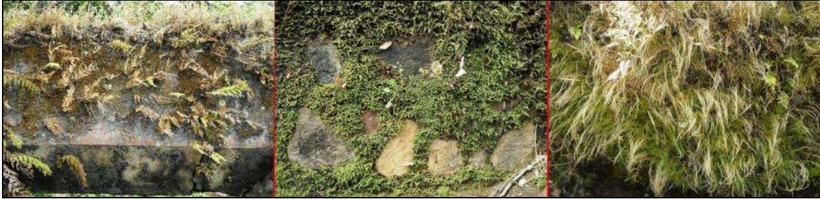
Figura 44: En las tres imágenes se muestran los tipos de helechos y microflora presentes en las paredes de las ruinas (Fotografías: Sosa, 2014).
