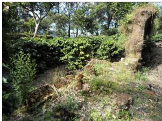
Figura 50: En el primer plano de la imagen se pueden ver acúmulados, y en pleno procesos de deterioro, los restos colapsados de la casa (Fotografía: Sosa, 2014).
