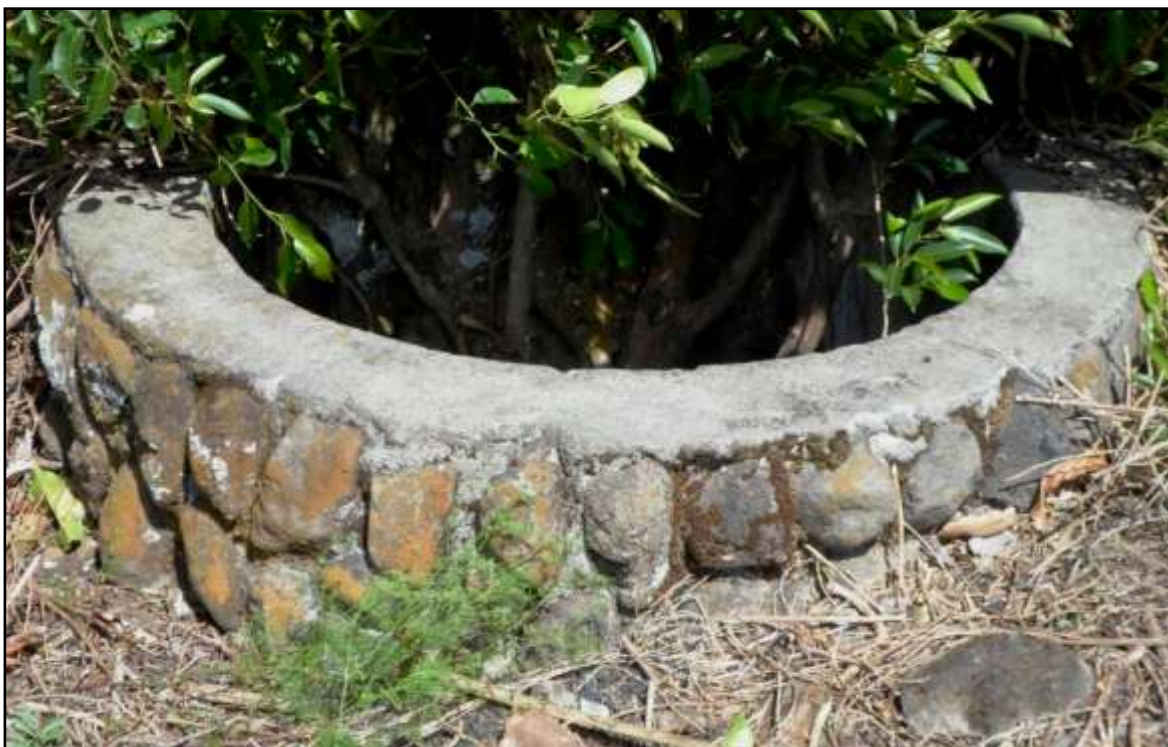
Figura 37. Rasgo 5: Imagen de RFST-6 o pozo de abastecimiento de agua para el abrevadero y otros posibles usos (Fotografía: Sosa, 2014).
