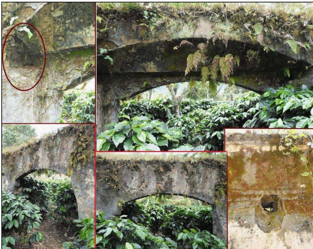
Figura 18: Fotografías de la única puerta de la casa y de los agujeros donde estaban colocadas las vigas. El ovalo muestra el espacio vacío donde estaban ubicados los goznes de la puerta (Fotografía: Sosa, 2014).
