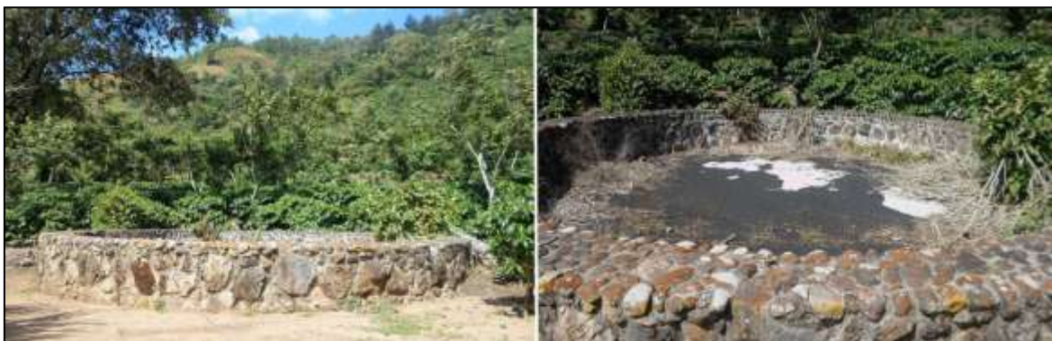
Figura 38. Rasgo 6: Imágenes del abrevadero construido con piedra de canto rodado, mezcla de cal y cemento (Fotografía: Sosa, 2014).
