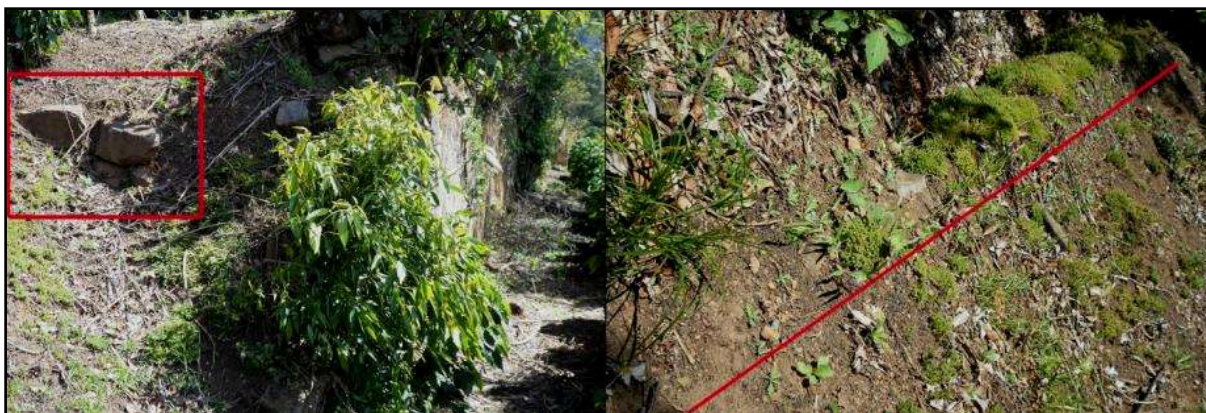
Figura 34: Rasgo 3: Dentro del recuadro, izquierda, restos de muro de una posible terraza. Derecha, restos del muro de contención (Fotografía: Sosa, 2014).
