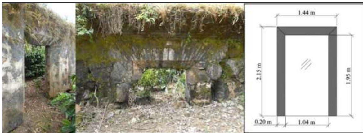
Figura 17: En estas imágenes se muestran las particularidades, estado y medidas de las ventanas de la casa (Fotografías y dibujo: Sosa, 2014).
