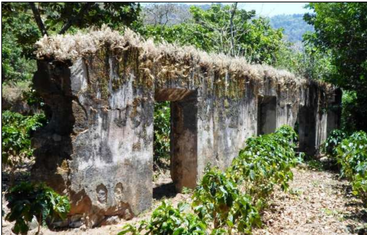
Figura 26: Panorámica que evidencia el estado actual de la fachada sur, donde se ubica la única puerta. RFST-1-4 o Fachada Sur (Fotografía: Sosa, 2014).
