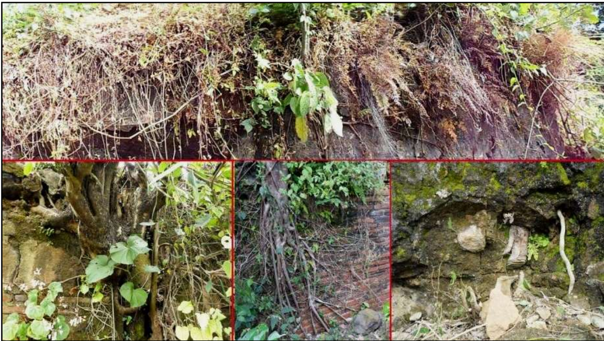
Figura 43: En la imagen de arriba se puede ver el abultado y desmedido crecimiento de helechos sobre la cabeza de los muros de la fachada norte de la casa. En las imágenes de abajo se puede apreciar como las raíces de la macroflora tienen su efecto negativo sobre las estructuras del sitio (Fotografías: Sosa, 2014).
