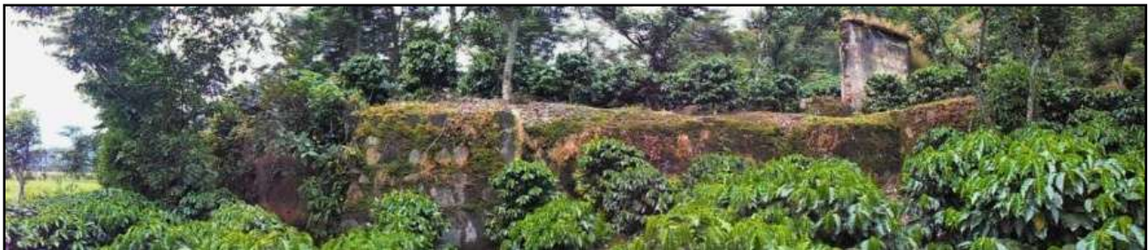
Figura 32: Rasgo 3: Panorámica de parte del muro de contención, tomada desde el lado oeste (Fotografía: Sosa, 2014).
