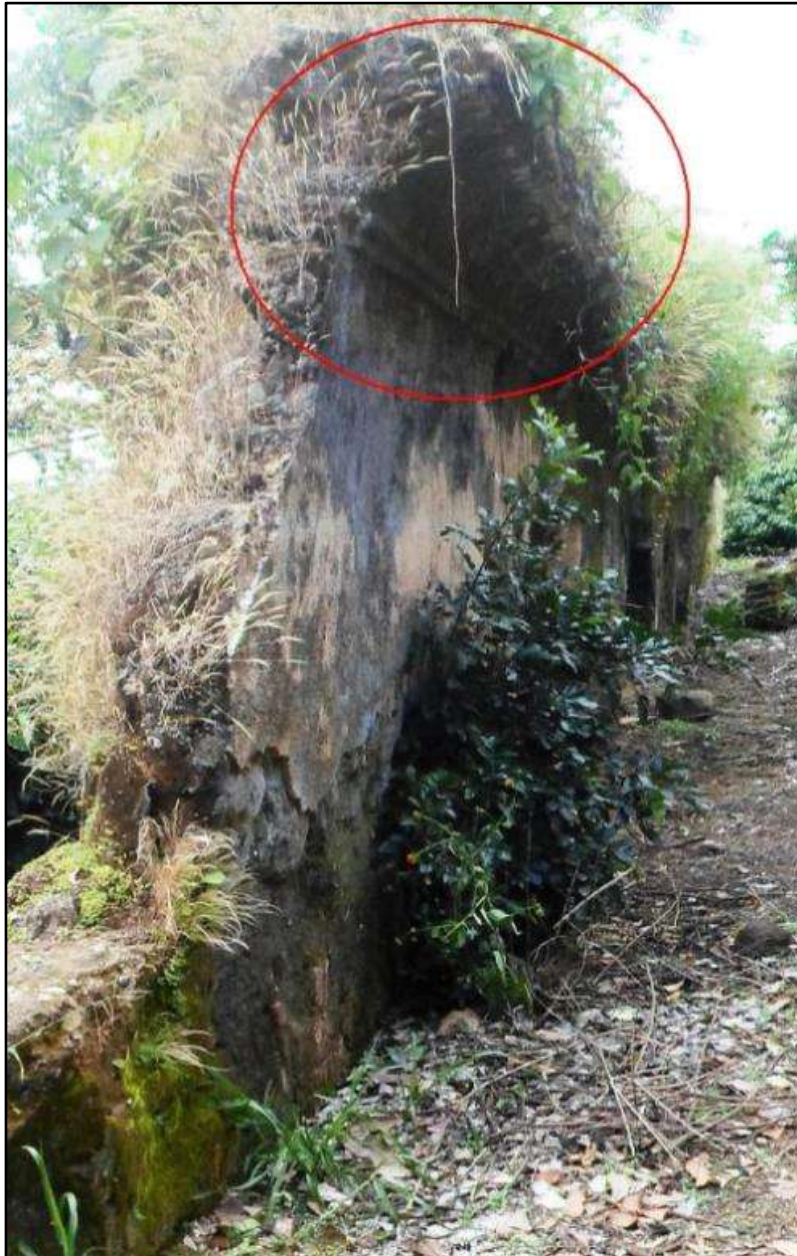
Figura 41: Dentro del óvalo se muestra el caveto y el bocel agregados decorativos de la Casa de las Ventanas (Fotografía: Sosa, 2014).
