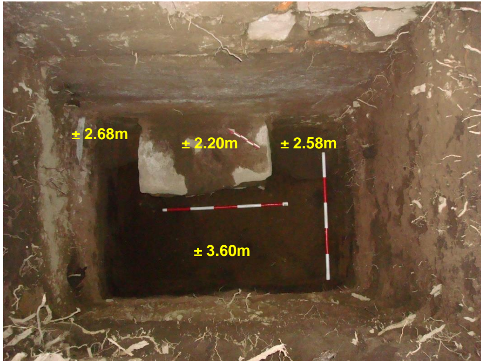
Figura 31 Fotografía de cimiento en I – 10 (Juan Pablo Herrera, 2012)
