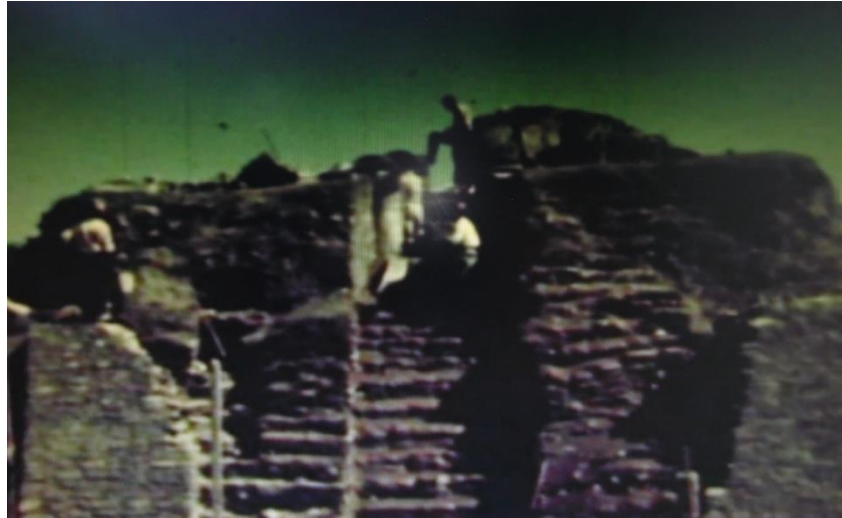
Figura II.10: Estructura 6 de Zaculeu durante los trabajos de reconstrucción de la UFCO en 1946. (Tomado de UFCO, 1949).
