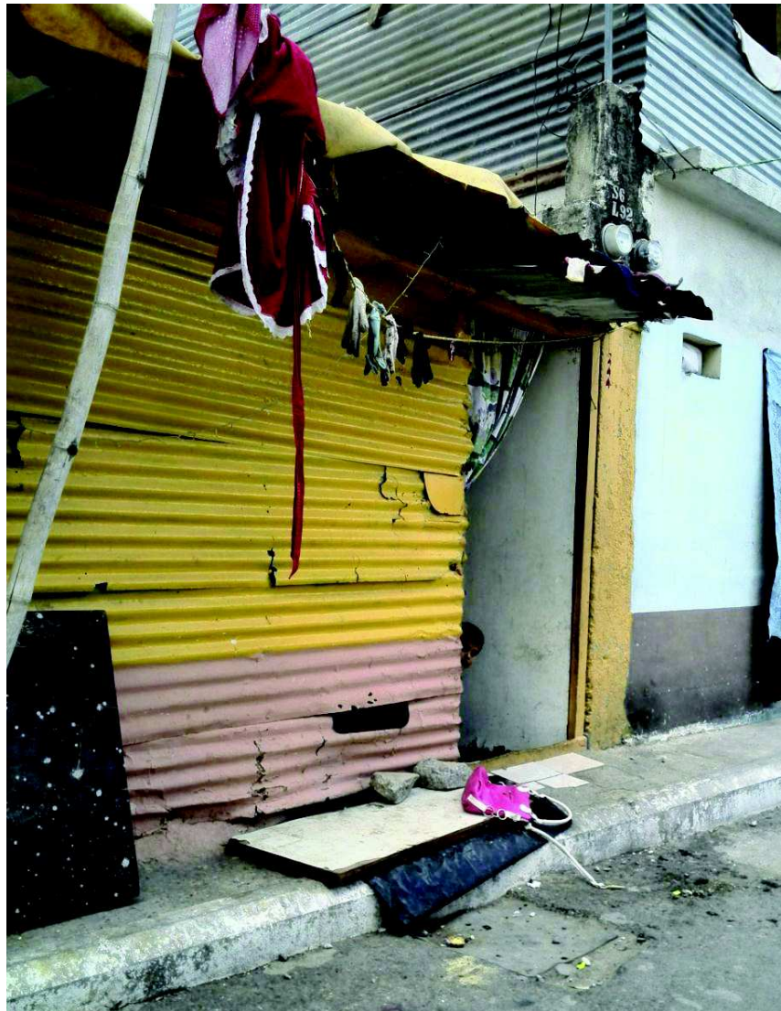
Vivienda de lámina sobre calle principal del asentamiento El Recuerdo
