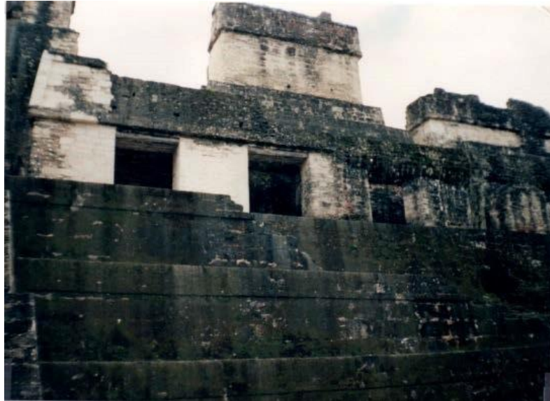
Imagen 10 Bóveda y muro - este - restaurado
