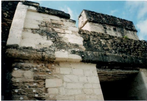
Imagen 2. Bóveda exterior y muro frontal - este- .
