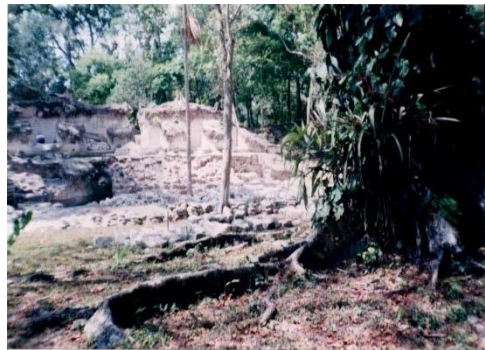
Imagen 6 Muros al descubierto de un monumento
