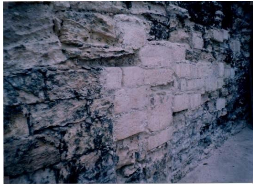
Imagen 11 Muro Central - Oeste - siendo restaurado
