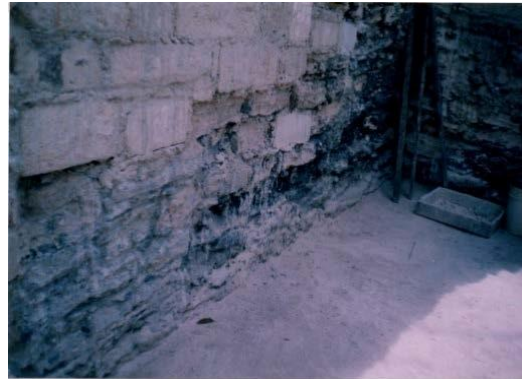
Imagen 12 Muro central –norte avanzada desintegración
