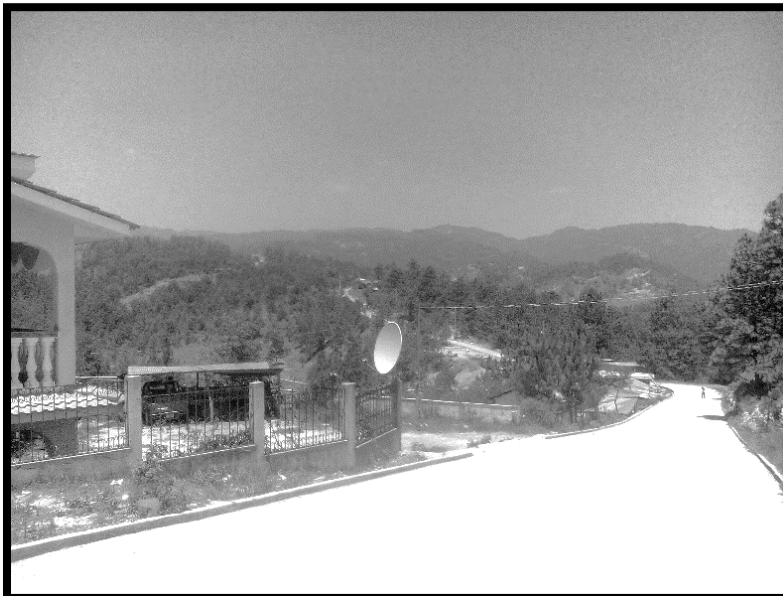
Fotografía No. 34 Camino principal de cemento hacia la aldea Parraxchaj. Fuente: Amalia Tzunux.
