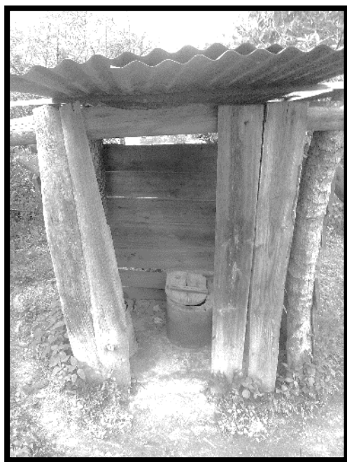
Fotografía No. 28 Se observa una letrina que se ubican fuera de las casas. Fuente: Amalia Tzunix.
